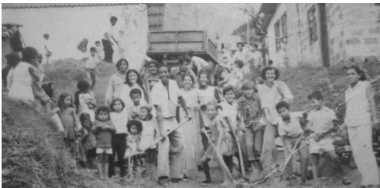
Inicio de pavimentación de las calles en Villa Socorro y volqueta del municipio descargando material. Convite en la calle 104 E. Medellín, 1970. Tomado del Periódico Mi Comuna 2 (Abril 2014)
