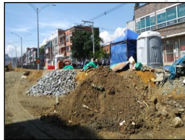
Imagen 5. Agregados usados en obra para llenos, base y subbase para la construcción de vías en obra y material de excavación de obra Urgencia manifiesta METROPLÚS (Envigado Antioquia). Fuente: Propia
