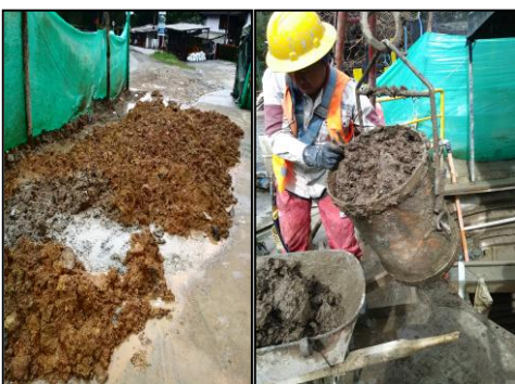
Imagen 3. Material resultante de excavación en las Obra VSN. Fuente: Propia
