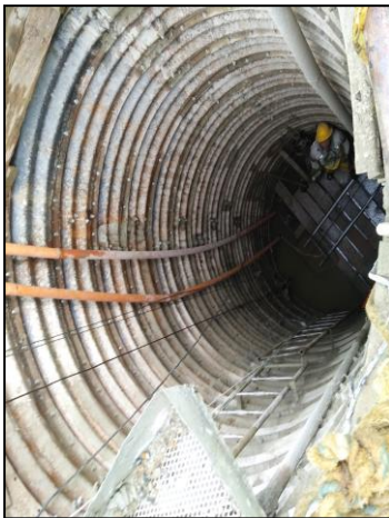
Imagen 1. TUNNEL LIER Obra Valle San Nicolás VSN. Fuente: Propia
