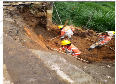
Imagen 4. Actividades de excavación Manual obra OESAP. Fuente: Propia
