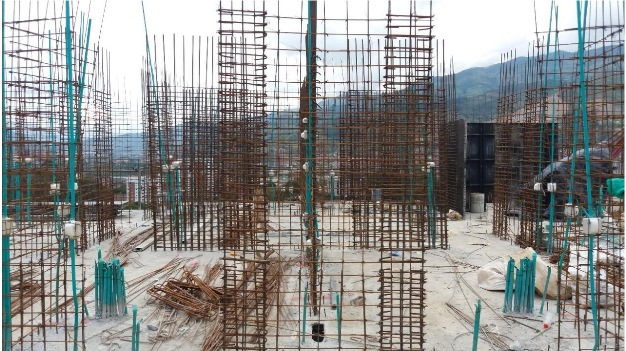
Foto 2, Malla electrosoldada instalada en edificio
