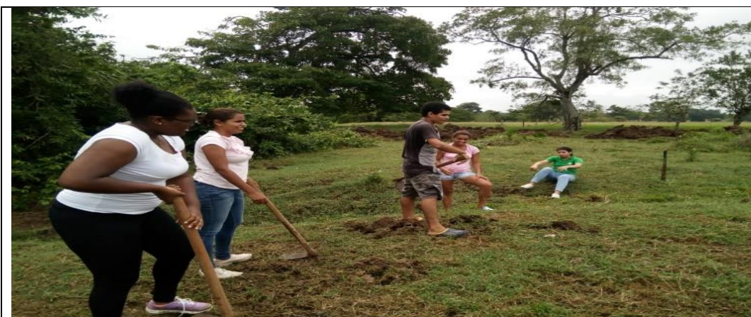
Figura 63. Movimiento de tierra
