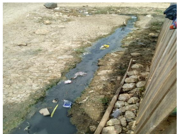
Figura 17. Zanjas o alcantarillado llenos de desechos
