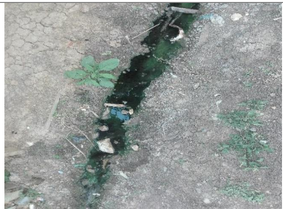
Figura 16. Residuos sólidos en zanjas o alcantarillado provisional
