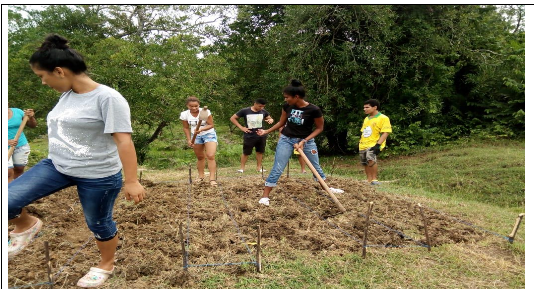
Figura 66. Segundo fase de movimiento de tierra
