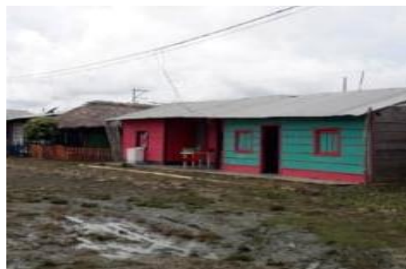
Figura 8. Calle sin pavimentar y en mal estado
