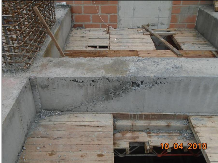
*Figura 23 Viga VA-2-6 (50x70) para Sección de Cortante Losa 9 con junta fría por vaciado irregular
