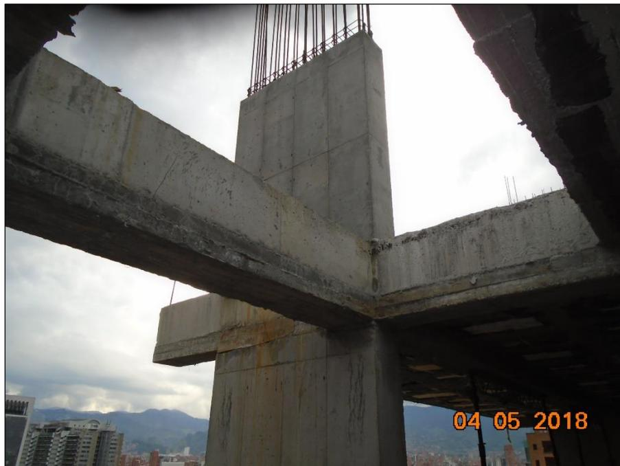
*Figura 24 Viga VA-2-6 (50x70) para Sección 1-1 de Cortante Losa 9 (fuente: Archivos Propios)*
