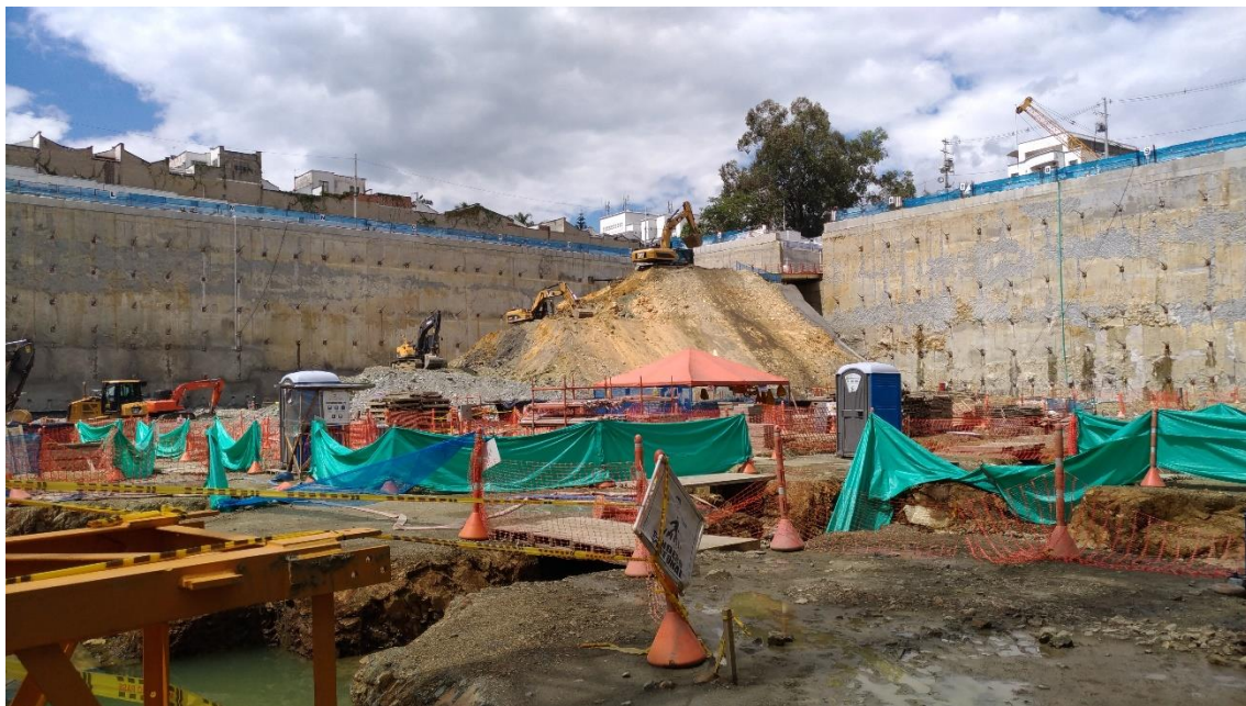
Fotografía 3 – Contención tipo suelo pernado (Soil Nailing) – A la izquierda: Envigado, Antioquia y a la derecha: Sabaneta, Antioquia
