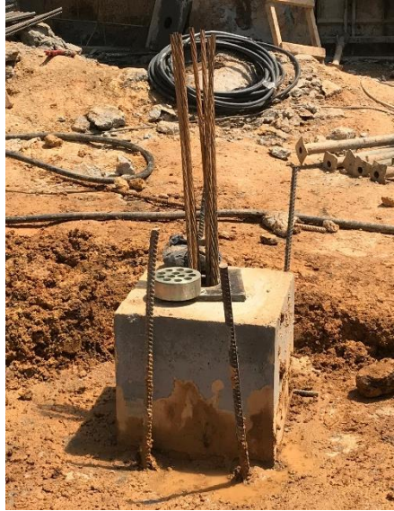
Fotografía 9 - Placa y bloque de acero para el tensionamiento de anclajes
