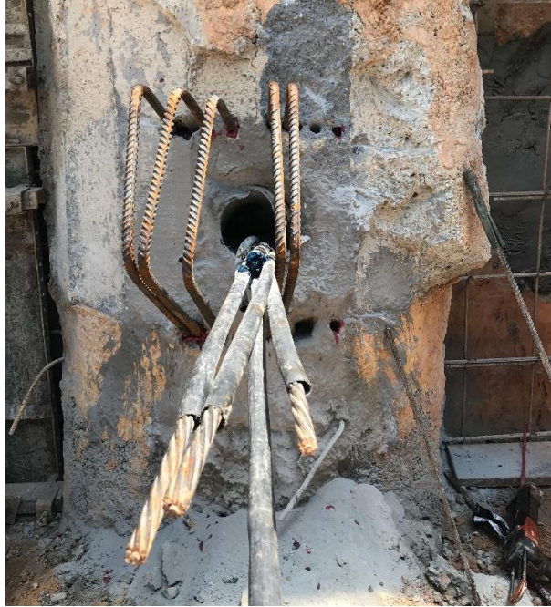
Fotografía 6 - Perforación equipada con anclaje
