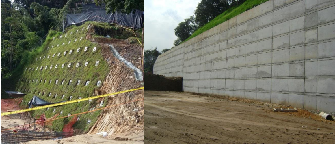
Fotografía 3 – Contención tipo suelo pernado (Soil Nailing) – A la izquierda: Envigado, Antioquia y a la derecha: Sabaneta, Antioquia
