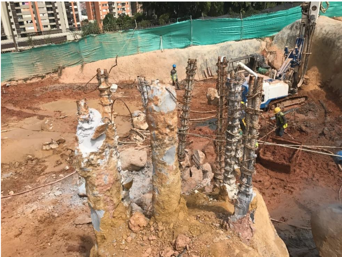
Fotografía 2 - Cimentación tipo micropilotes - Sabaneta, Antioquia
