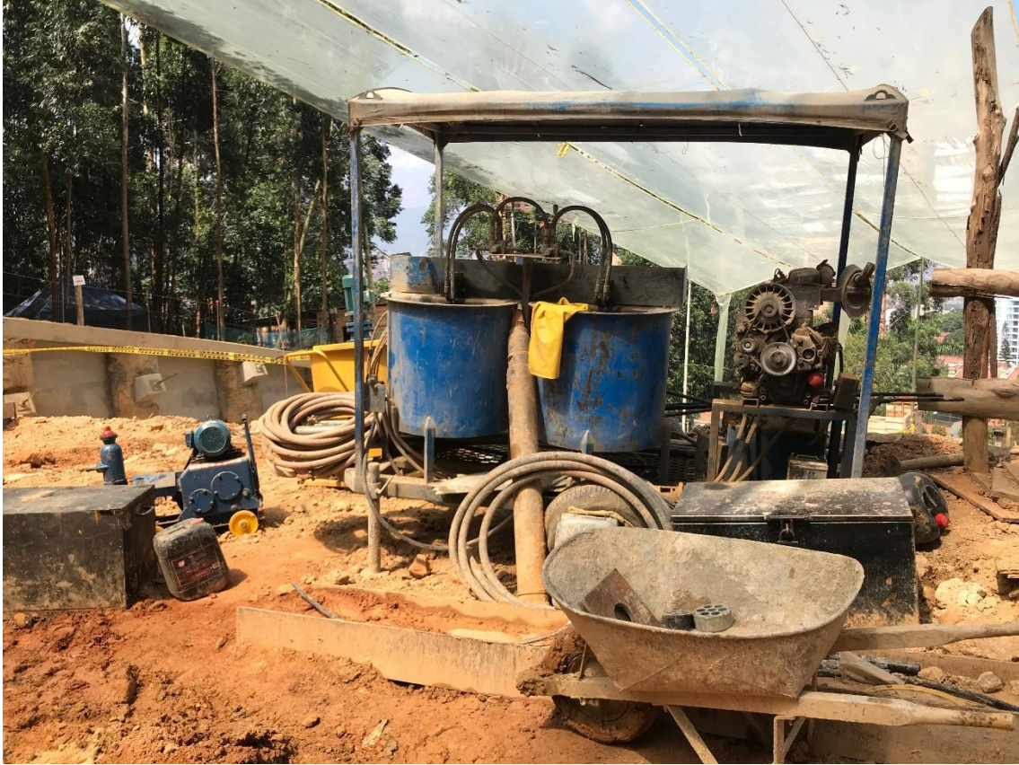
Fotografía 7 - Mezcladora, bomba y tubería de llenado
