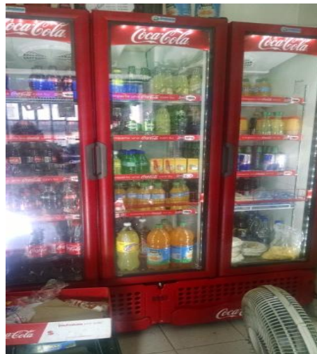
Foto 4 interior enfriadores tienda El Profe
