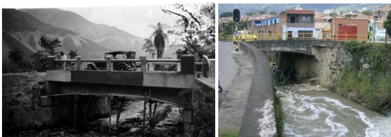
Puente de La Toma, sobre la quebrada Santa Elena. Izquierda: puente “quebrada arriba”, Medellín, principios s. XX. Derecha: puente de La Toma, Medellín, 2008.
