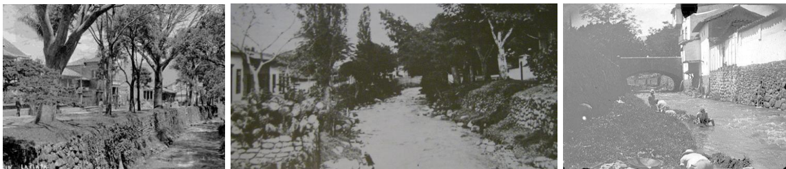
Izquierda: La playa y Quebrada Santa Elena, 1898. Centro: Puente Junín al fondo 33 , 1905. Derecha: Puente Junín sobre la quebrada Santa Elena, nótese el “balconcito excusado”.
