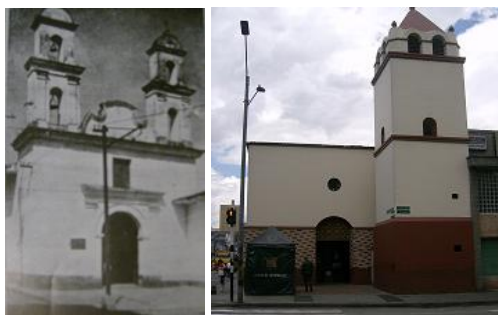
Izquierda: iglesia de San Juan de Dios, Medellín, construida de 1802 a 1805. Calle Colombia con carrera Cúcuta 231 , contigua a ésta quedaba el Hospital. Derecha: iglesia San Juan de Dios, 2008.
