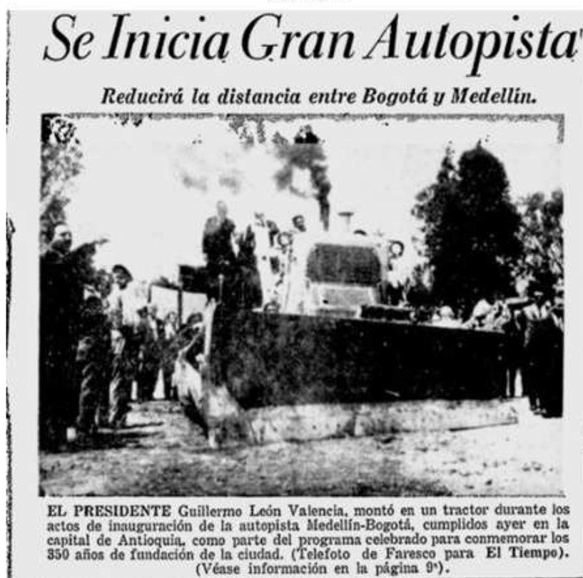
Figura 2: Inicio de los trabajos de construcción del tramo Medellín-El Santuario
