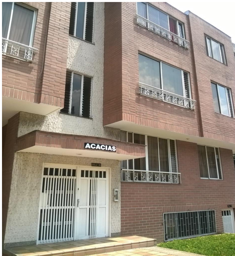
Edificio donde vivía Inca en el barrio Laureles.
