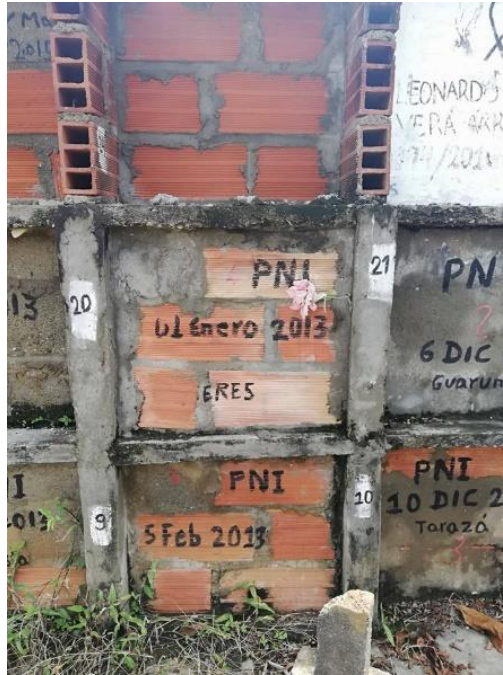
Fotografía N° 7: Bóveda de CNI, cementerio municipal, Cáceres.
