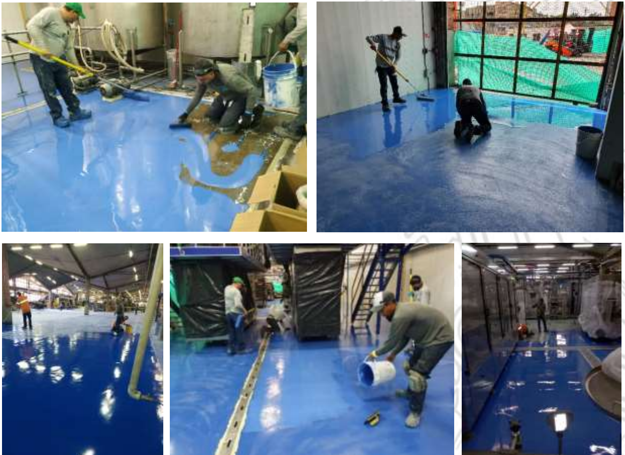
Figura 30-34. Aplicación de recubrimiento por capas de producto (Elaboración propia).
