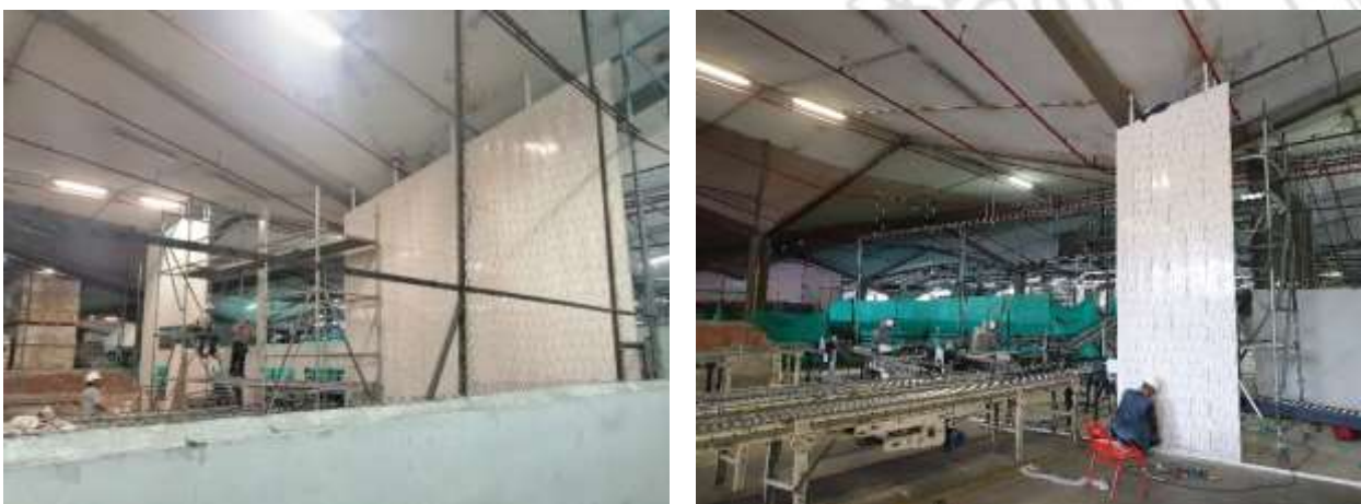
Figura 25-26. Construcción de muros PVC (Elaboración propia).
