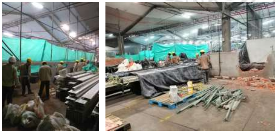
Figura 23-24. Demolición de muros medianeros en mampostería (Elaboración propia).
