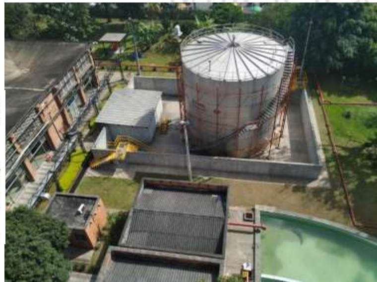
Figura 16. Tanque almacenamiento de alcohol (Elaboración propia).
