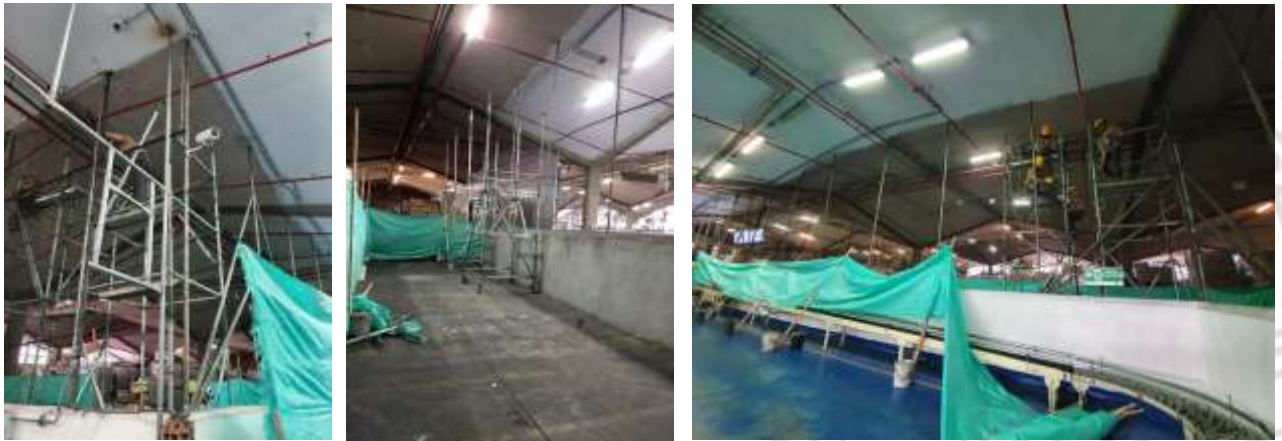
Figura 20-22. Desmonte de malla eslabonada (Elaboración propia).
