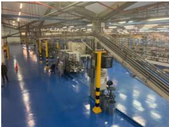
Figura 10-13. Reconstrucción de Pintura de Piso Epóxica en la Envasadora. (Elaboración propia).
