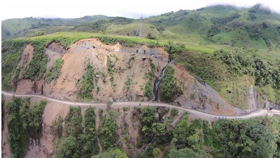
*Figura 1. Zona de intervención crítica afereente a las torres de energía (EVALTEC S.A, 2019).*
