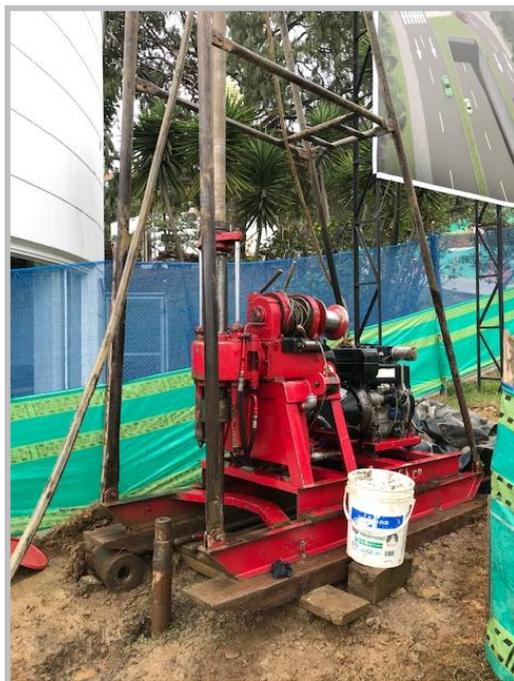
Figura 5. Máquina de perforación X-Y-1-2 (Fuente propia).
