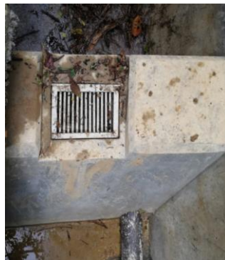
Figura 1. Bocatoma sumergida o de fondo
