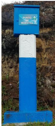
Figura 5. Punto de muestreo tipo pedestal
