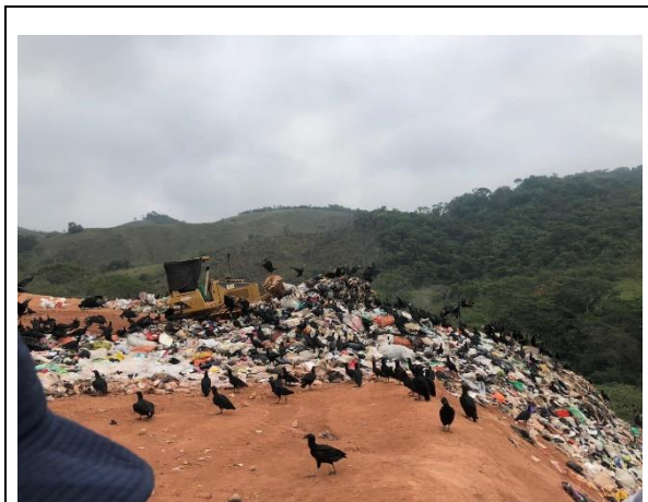
Foto 3, Esparcimiento y compactación de los residuos por medio mecánico.
