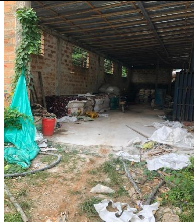
Foto 6, Espacio para el almacenamiento del material recolectado con infraestructura deficiente.
