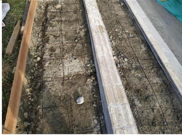
**Ilustración 42: Desperdicio en la llave o viga de contención**
