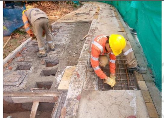
**Ilustración 18: Instalación de malla electrosoldada**
