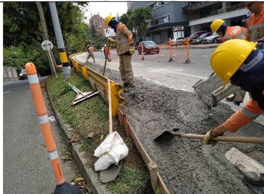
**Ilustración 20: Vaciado de concreto**
