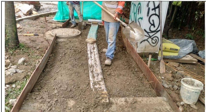
**Ilustración 16: Instalación de formaleta y excavación de llave**
