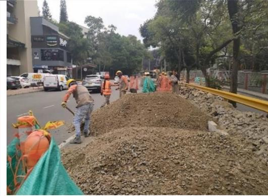
**Ilustración 49: Base granular contaminada**
