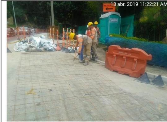
**Ilustración 17: Instalación de malla electrosoldada**
