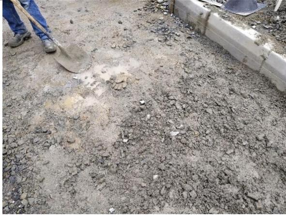
**Ilustración 34: Base instalada, no protegida**
