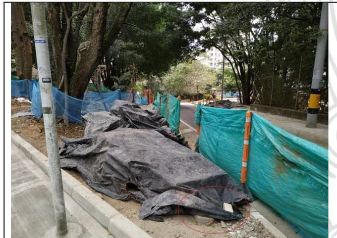
**Ilustración 57: Uso inadecuado de los adoquines**
