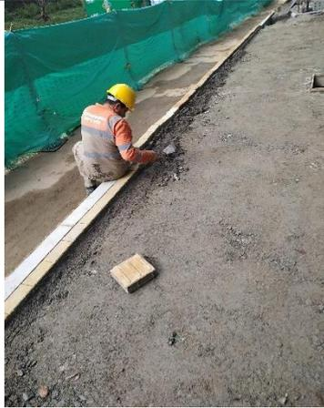
**Ilustración 14: Instalación de adoquines**
