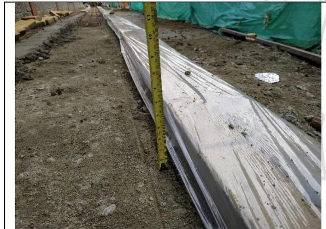
**Ilustración 44: Aumento del espesor de la losa**
