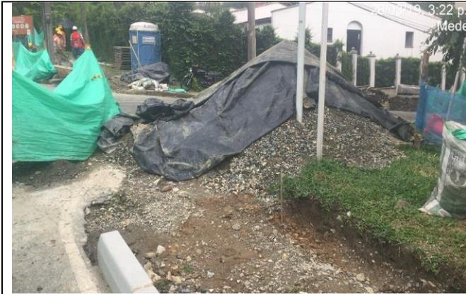
**Ilustración 45: Protección de la base granular**
