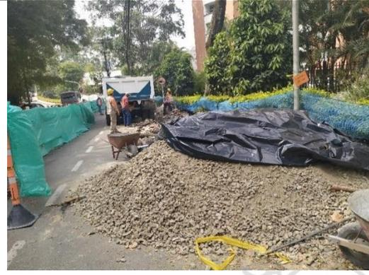
**Ilustración 50: Base granular contaminada**
