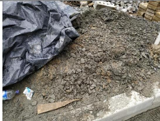
**Ilustración 46: Protección de la base granular**
