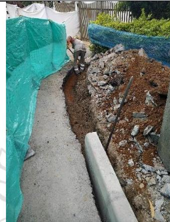
**Ilustración 11: Instalación de cordonería**
