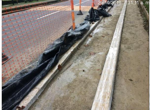
**Ilustración 35: Base instalada, no protegida**
