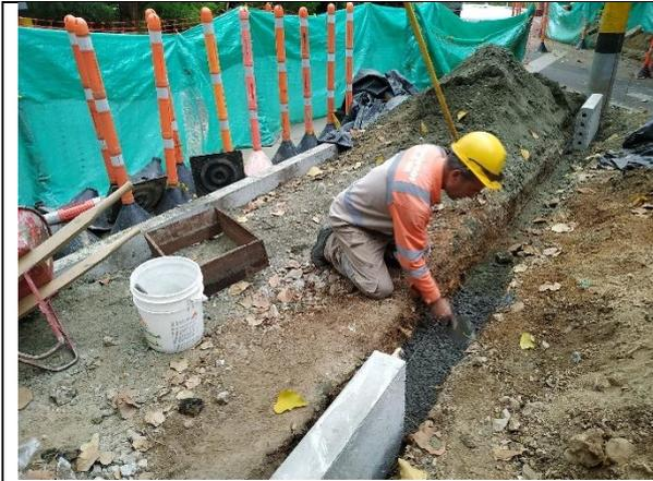
**Ilustración 10: Instalación de cordonería**
