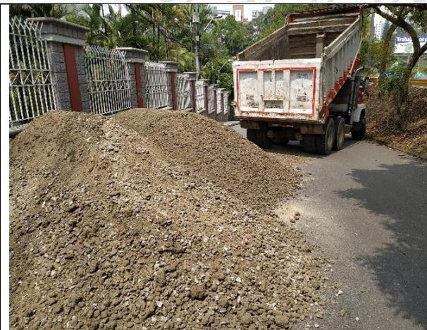
**Ilustración 48: Acopio de la base granular**
