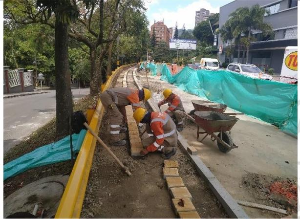
**Ilustración 15: Instalación de adoquines**
