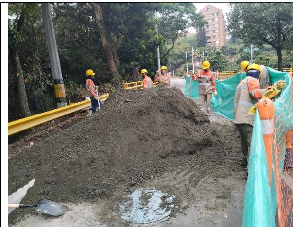
**Ilustración 47: Acopio de la base granular**
