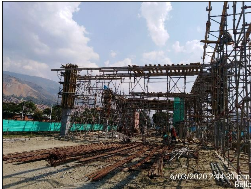
Figura 4. Acopios del material bien identificados.
