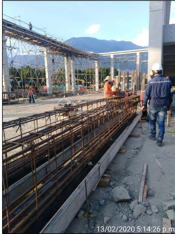
Figura 2. Instalación de acero en vigas.
