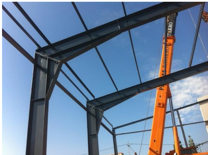
Ilustración 2. Pórtico con perfiles de alma llena
