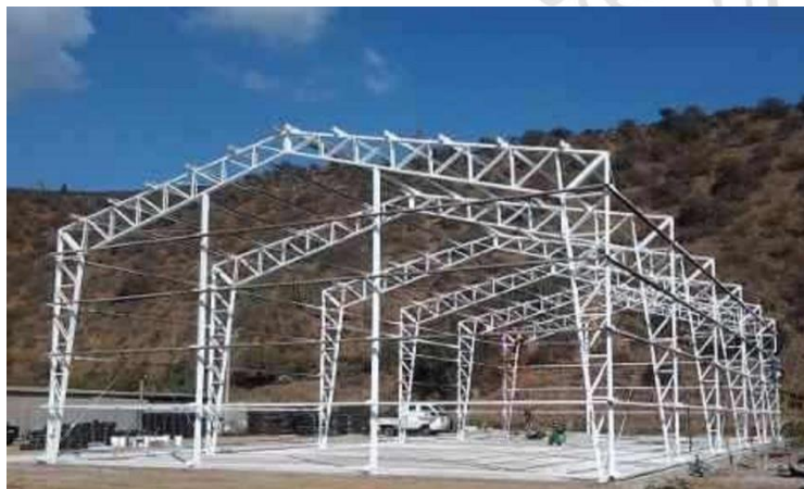
Ilustración 1. Pórtico en celosía
