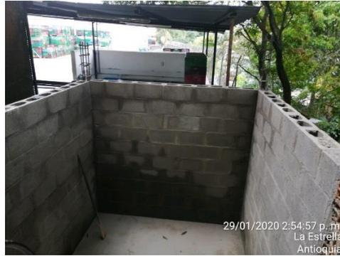
**Figura 28** Colocación de las hiladas de bloque de concreto.
