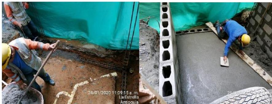
**Figura 27** Vaciado de la viga de fundación Vaciado del concreto para la losa de fundación con nivelada de este
