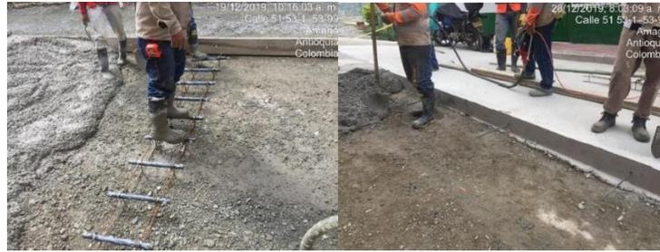
**Figura 24** Juntas transversales y Juntas longitudinales.
