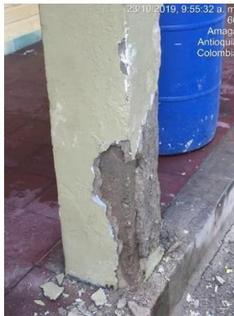
**Figura 19** Las columnas del patio del segundo piso deteriorado.
