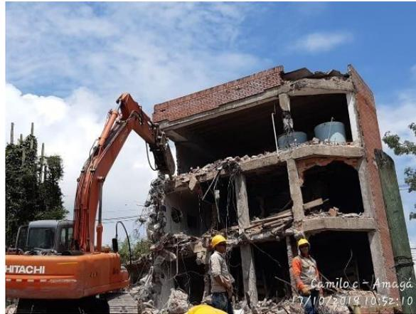
**Figura 3** Avance de la demolición mecánica.
