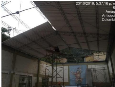
**Figura 20** Colocación de las tejas de fibra de cemento del aula múltiple sobre la estructura.
