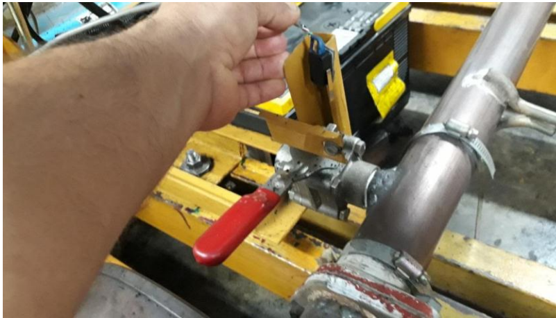
Ilustración 33. Montaje del Final de Carrera en la Válvula
