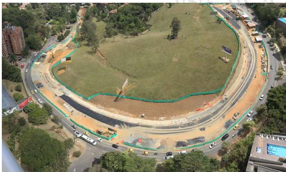
Figura 3. Avance de obra mes de agosto
