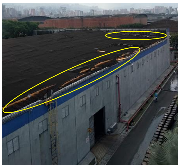
Fotografía 10. Costado sur bodega número 3.
