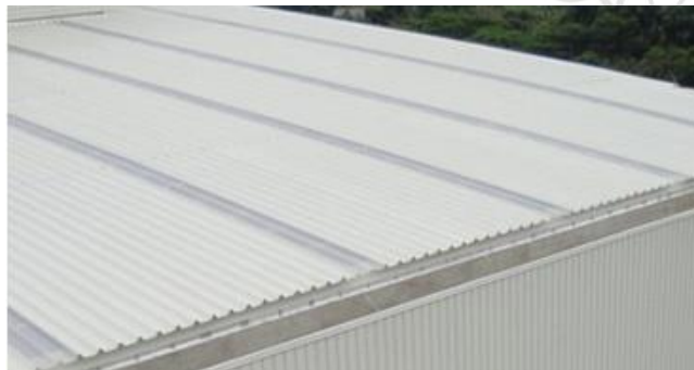
Fotografía 15. Ejemplo de cubierta metálica con teja tipo standing seam. Fuente: Acesco (s.f). Tomado de: https://www.acesco.com.co/cubiertas/
