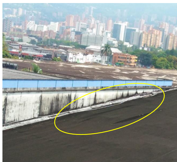
Fotografía 9. Costado norte bodega número 3.
