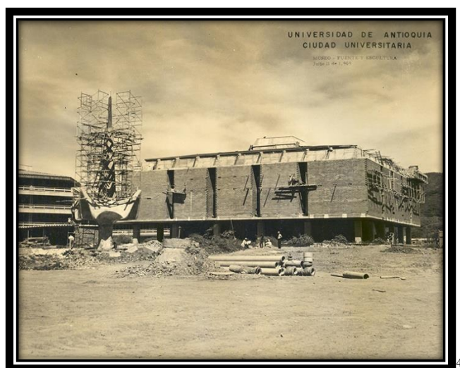
Fotografía 5. Construcción del Museo, fuente y escultura: “Hombre creador de energía”. Foto oficina de planeación U de A. 1969
