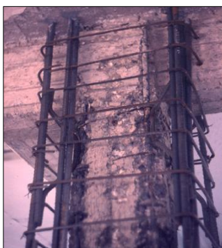
Ilustración 1. Reforzamiento de columnas con encamisado en concreto.
