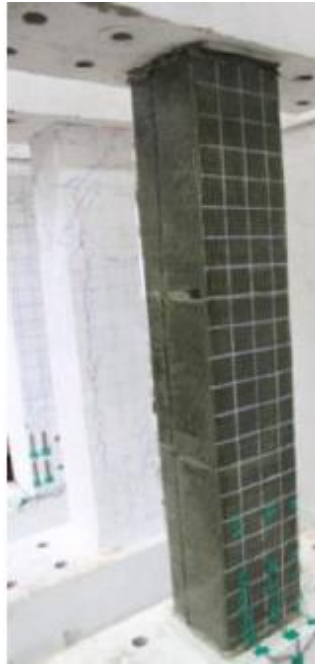
Ilustración 26. Proceso constructivo de recubrimiento en CFRP
