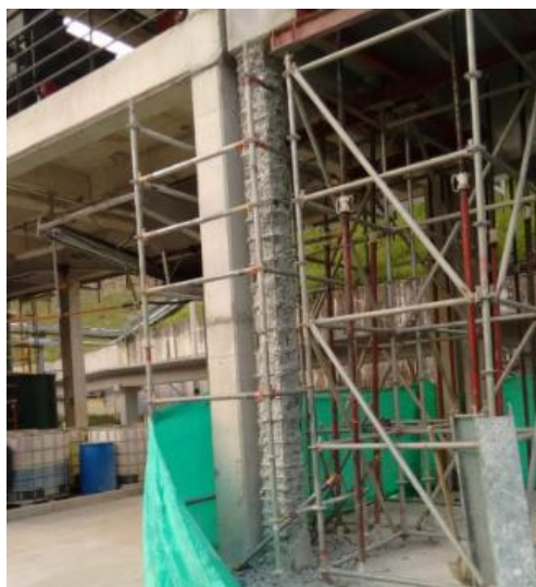
Ilustración 15. Proceso constructivo de encamisado en concreto
