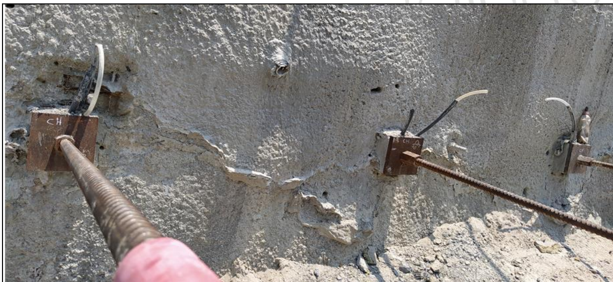
Imagen 11. Detalle barra Dywidag. Tomado de: elaboración propia.
