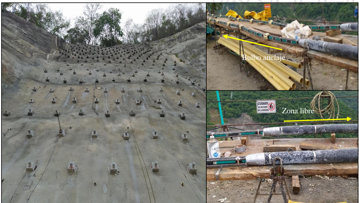
Imagen 9. Tratamiento finalizado - Sello tensor compuesto de cables o torones. Tomado de: elaboración propia.
