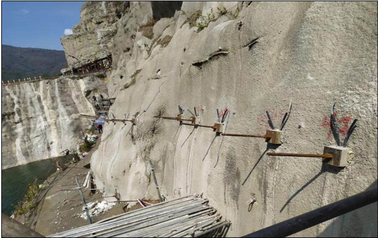
Imagen 10. Tratamiento activo correspondiente a tensores con barra Dywidag. Tomado de: elaboración propia.
