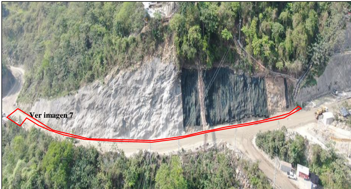
Imagen 6. Tratamiento de estabilización pasivo de sabana de pernos (barras de anclaje de 3 metros), drenajes, concreto lanzado. Tomado de: elaboración propia.
