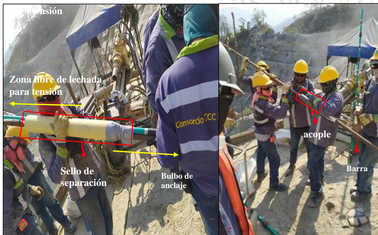
Imagen 5. Características principales de tensores acoplados por barras Dywidag. Tomado de: elaboración propia.
