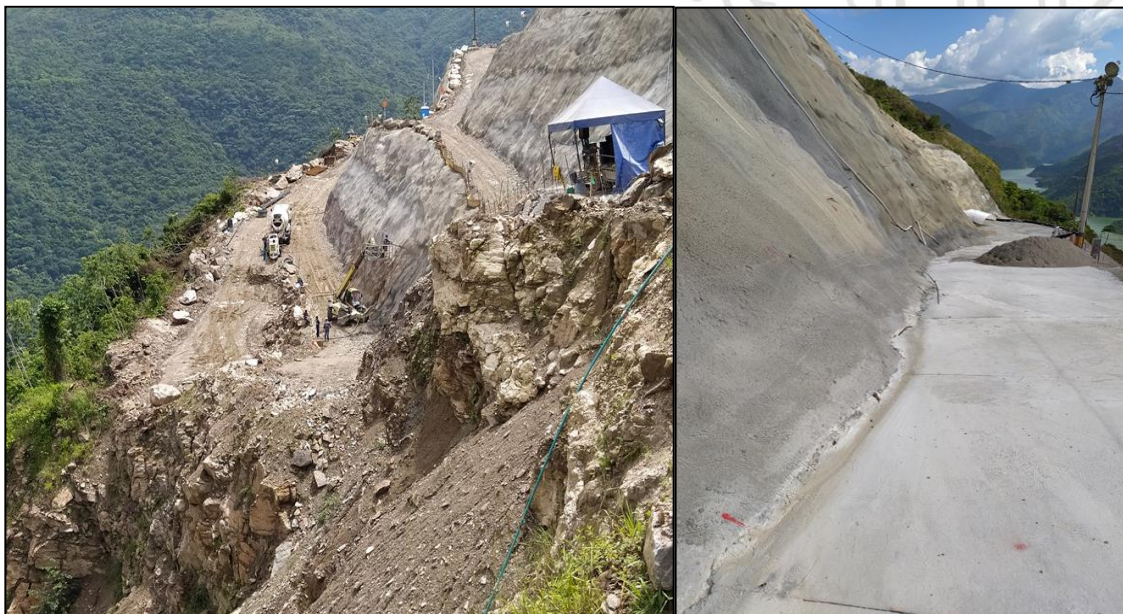
Imagen 3. Conformación y construcción de berma cuneta en concreto lanzado. Tomado de: elaboración propia.
