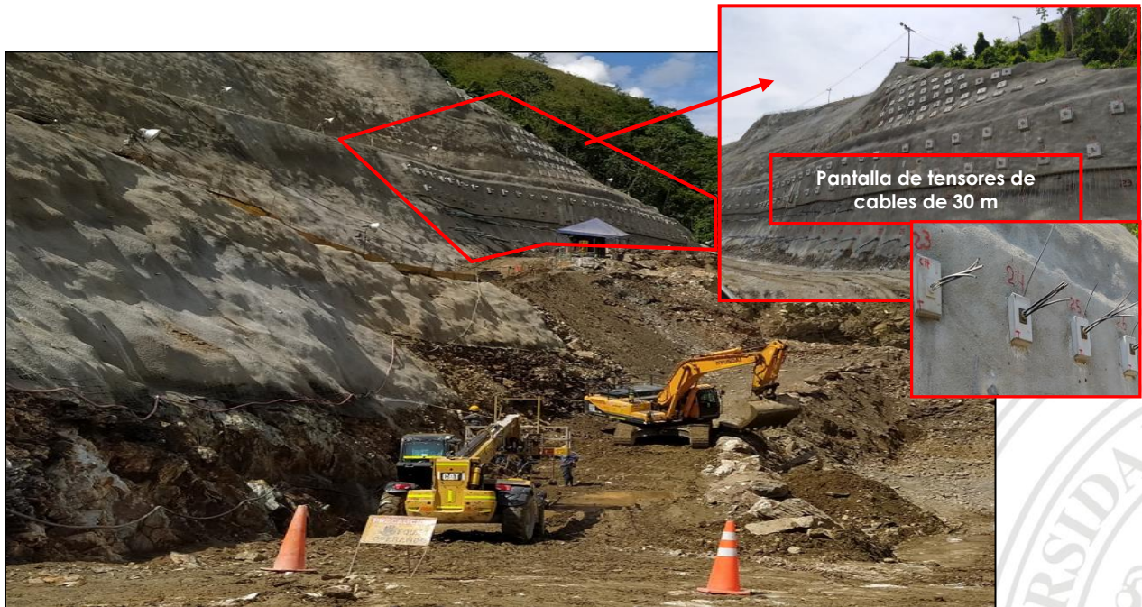
Imagen 2. Estabilización con bermas cuneta y anclajes (activos o pasivos) según las condiciones de roca encontradas en el avance y del plano constructivo. Tomado de: elaboración propia.
