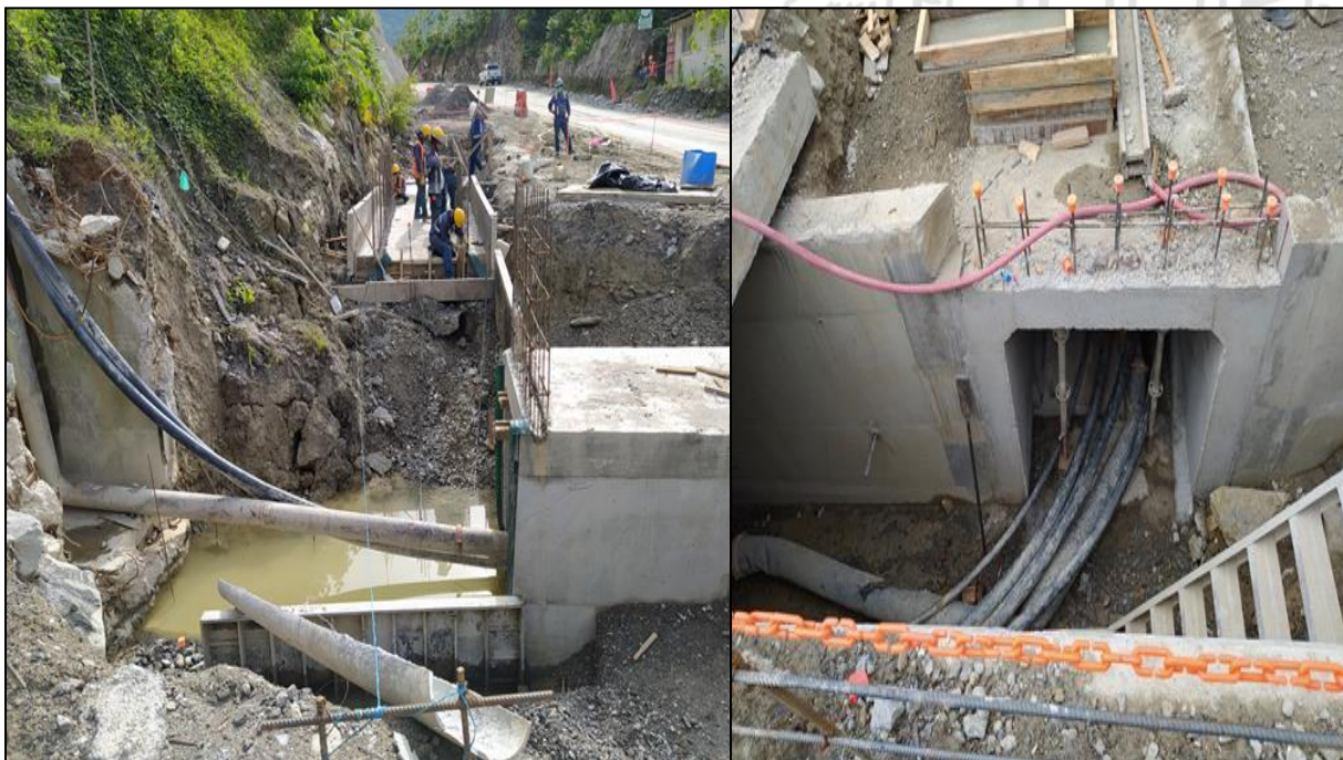
Imagen 7. Construcción de box culvert y canal en concreto reforzado, ver imagen 6. Tomado de: elaboración propia.
