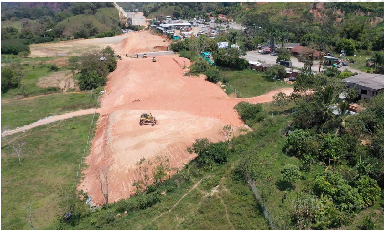
**Imagen 3.** Conformación del terraplén K19+000 – K19+550. **Fuente:** Dron equipo de Topografía.
