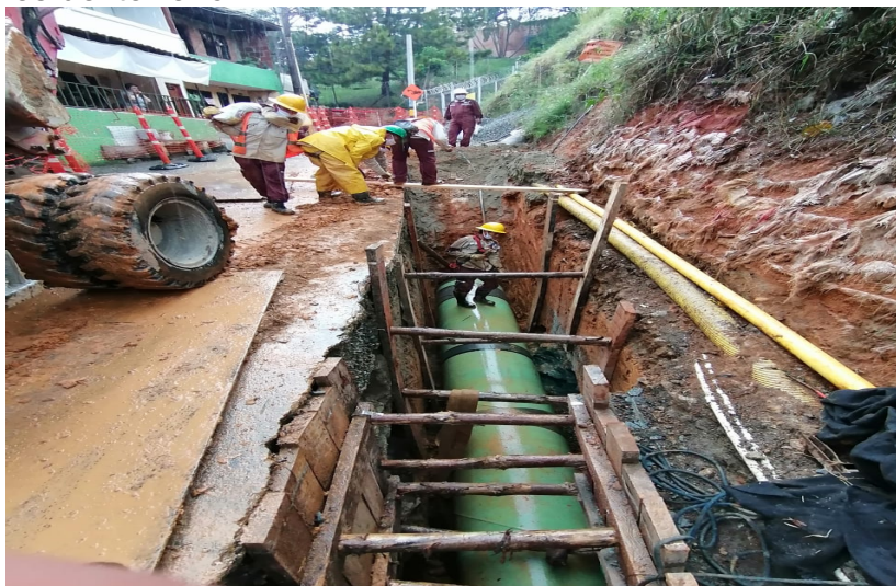
Ilustración 13. Excavación para tubería de 32 pulgadas.
