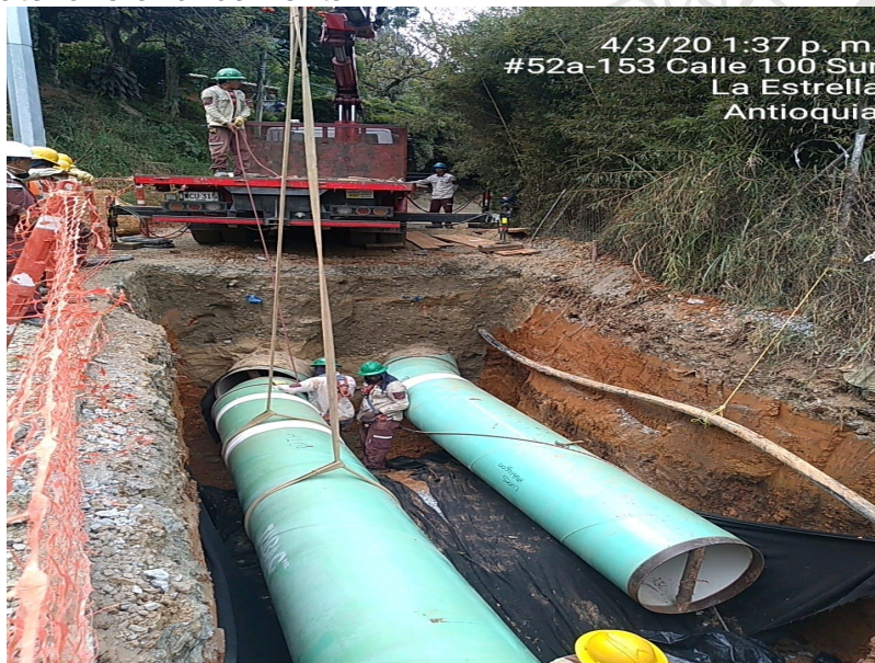
Ilustración 19. Excavación para dos tubos de 32 pulgadas.
