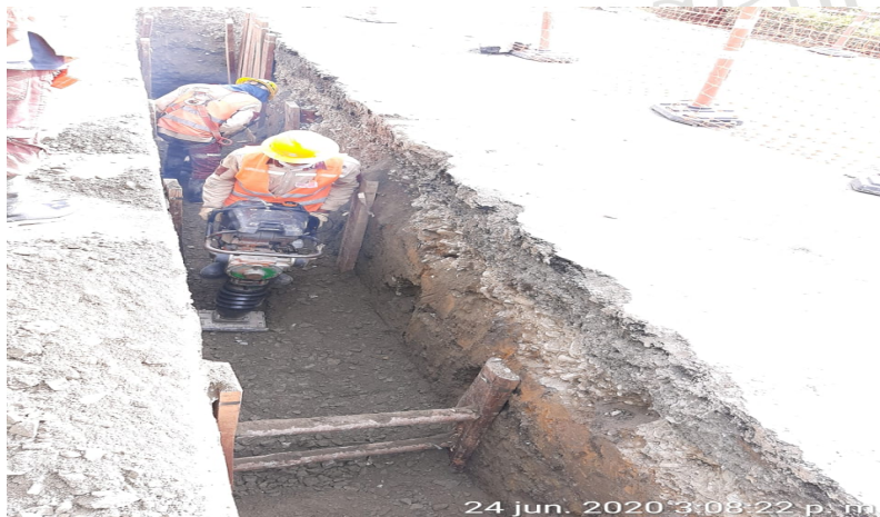
Ilustración 15. Proceso de lleno de excavación para tubería de 6 pulgadas.
