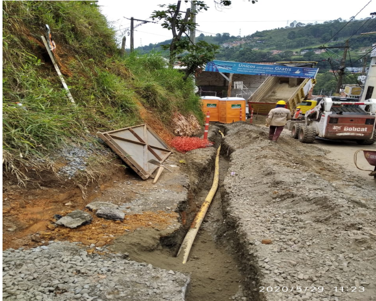
Ilustración 20. Excavación para mantenimiento de tubería de 4 pulgadas
