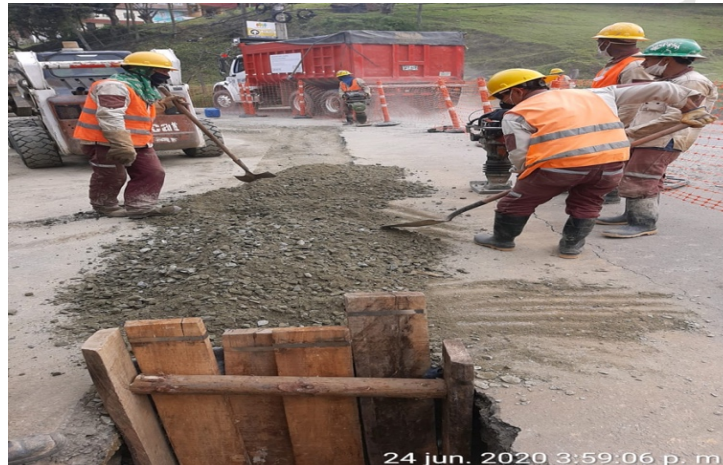
Ilustración 16. Finalización lleno excavación para 6 pulgadas.
