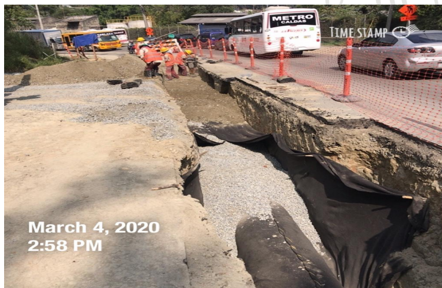
Ilustración 18. Proceso de lleno de excavación para tubería de acero de 32 pulgadas.
