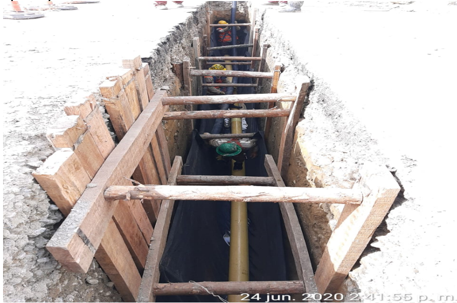
Ilustración 14. Inicio excavación para tubería de alcantarillado de 6 pulgadas.
