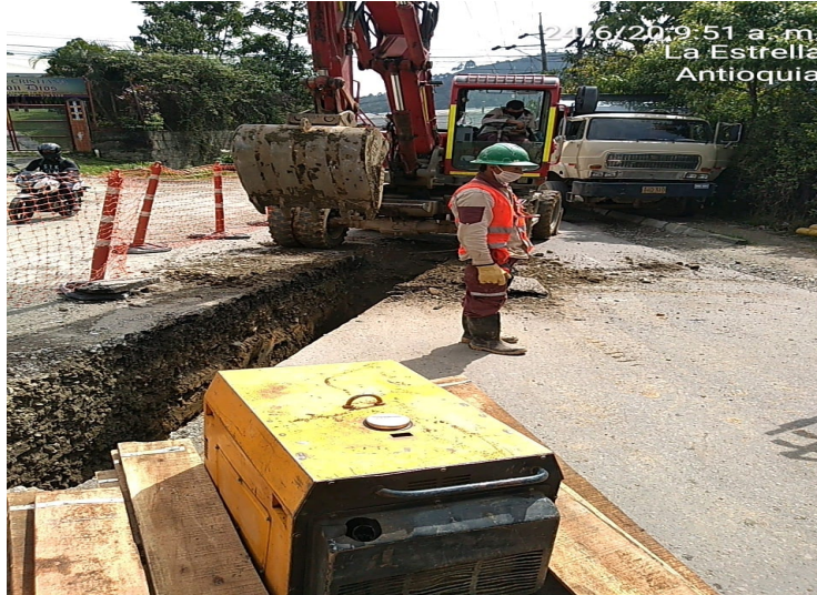
Ilustración 17. Maquinaria típica para excavaciones de tubería de 32 pulgadas.
