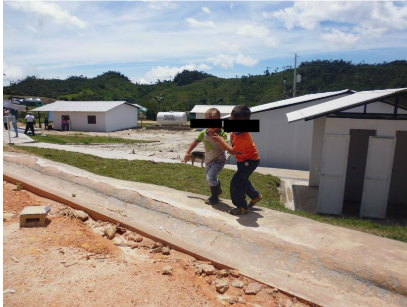
Imagen 14 ZVTN aún en construcción
