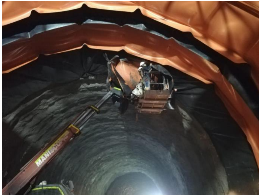
Fotografía 2. Instalación de geomembrana. Calzada Izquierda – Portal salida.
