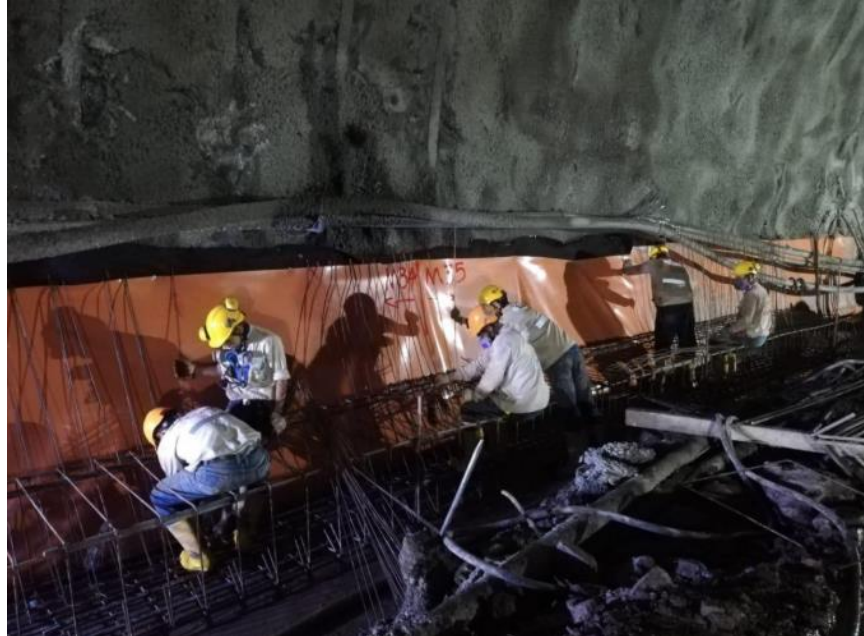
Fotografía 1. Armado de viga base. Calzada Derecha – Portal salida.
