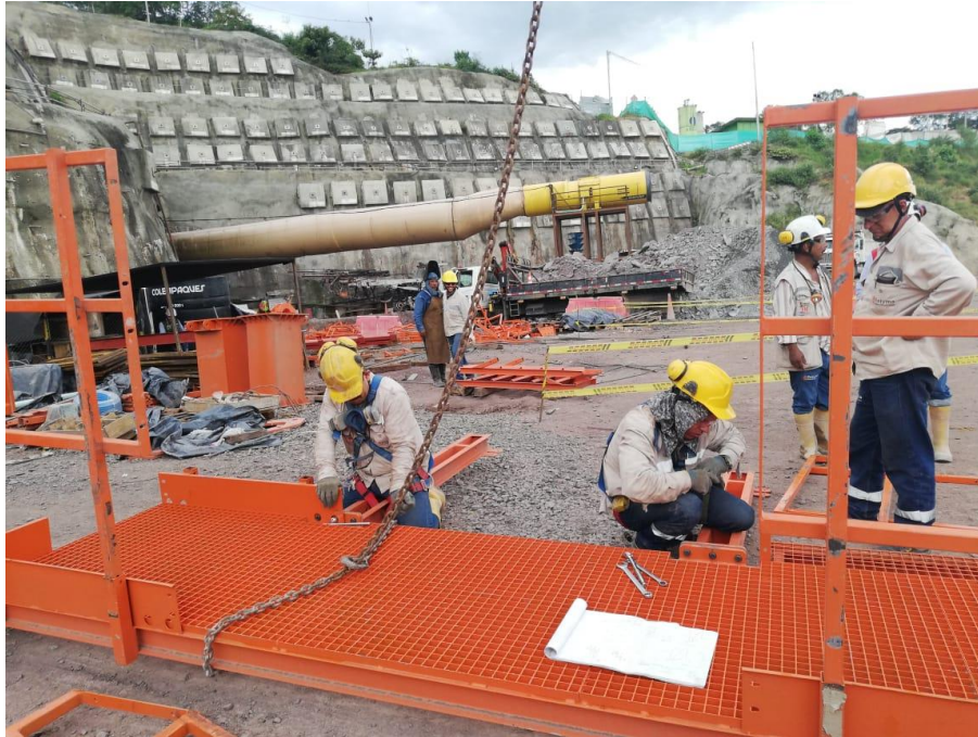
Fotografía 3. Armado de carro de avance. Calzada derecha – Portal salida.
