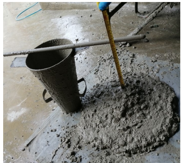
Imagen 8 Medición del asentamiento
