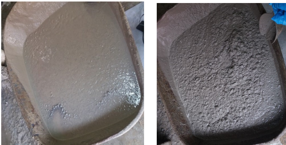
Imagen1 Mezcla segregada (Izquierda) y mezcla homogénea (Derecha). Fuente: Propia
