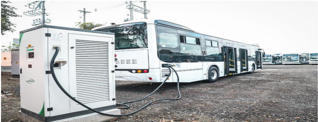
Figura 8: Torres de energía.
