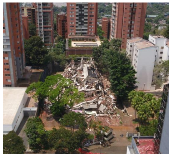
Escombros del edificio Mónaco
