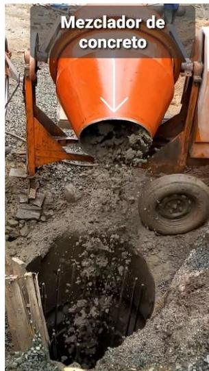
*Imagen 6. Proceso de vaciado de concreto*
