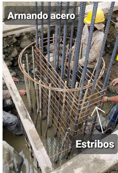
Imagen 22. Estructura de acero de la columna
