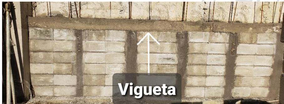
Imagen 38. Desencofrado de la vigueta
