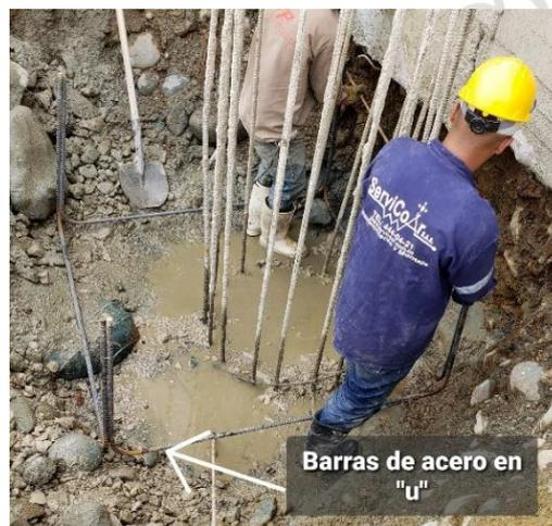
Imagen 8. Armado de refuerzo de acero
