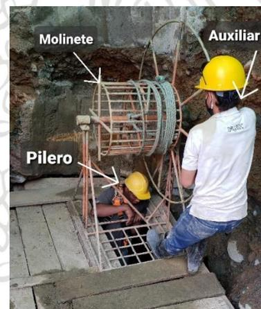
Imagen 1. Personal involucrado en el proceso de excavación
