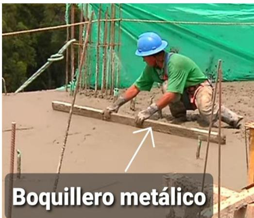
*Imagen 46. Verificación del espesor de la losa. Imagen tomada del video ¿Cómo se hace el vaciado de una losa de entrepiso?*
