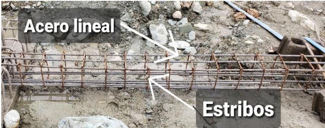
Imagen 16. Refuerzo de acero de la viga
