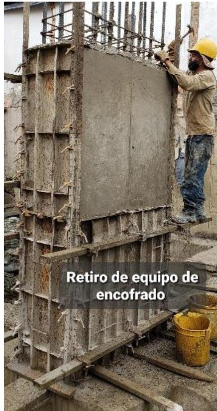
*Imagen 28. Desencofrado de la columna*
