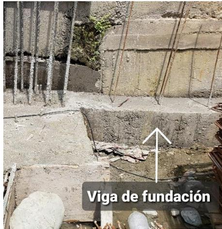
Imagen 21. Viga desencofrada
