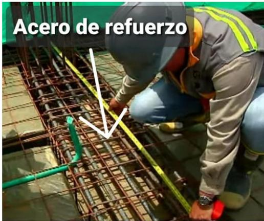
Imagen 42. Verificación aceros de refuerzo. Imagen tomada del video Armado de losa de entresuelo.
