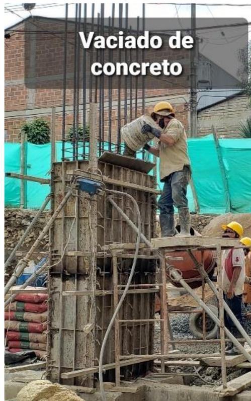
Imagen 26. Vaciado de concreto a la columna
