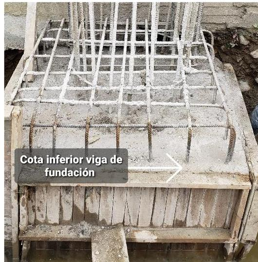
Imagen 12. Dado vaciado en concreto
