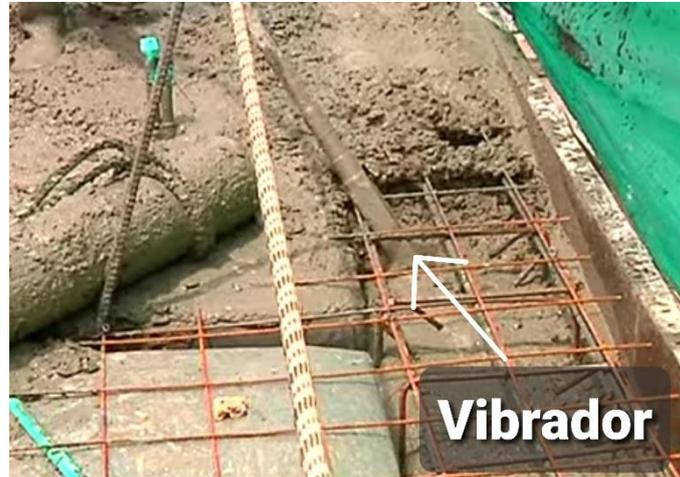
*Imagen 45. Vibrado del concreto. Imagen tomada del video ¿Cómo se hace el vaciado de una losa de entrepiso?*
