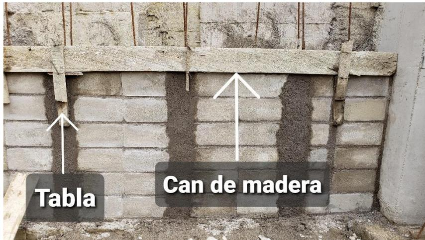
Imagen 37. Encofrado de la vigueta
