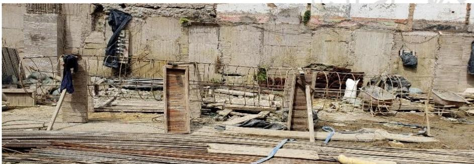
Imagen 4. Proceso de armado de la canasta de acero
