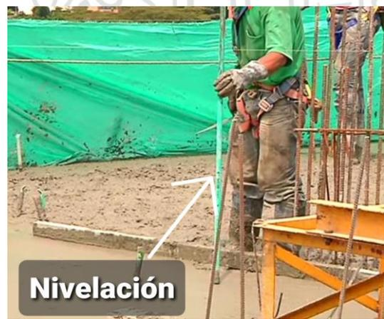
*Imagen 47. Verificación del nivel de la losa. Imagen tomada del video ¿Cómo se hace el vaciado de una losa de entrepiso?*
