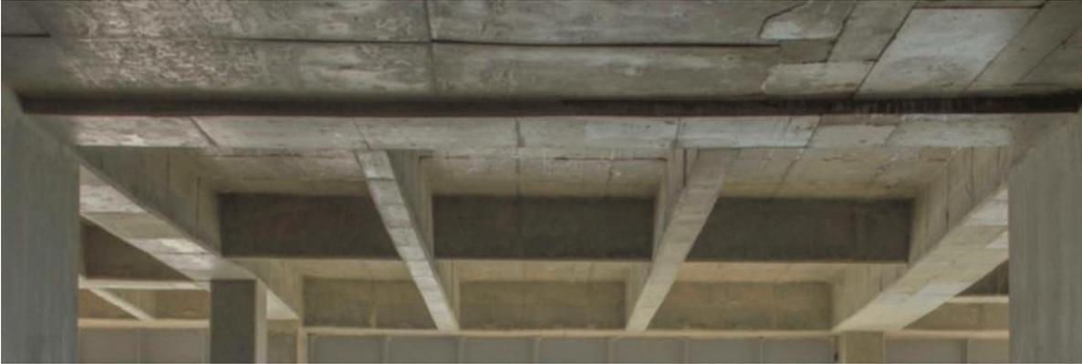
*Imagen 48. Losa de entrepiso curada y resanada. Imagen tomada del video Armado de losa de entrepiso*
