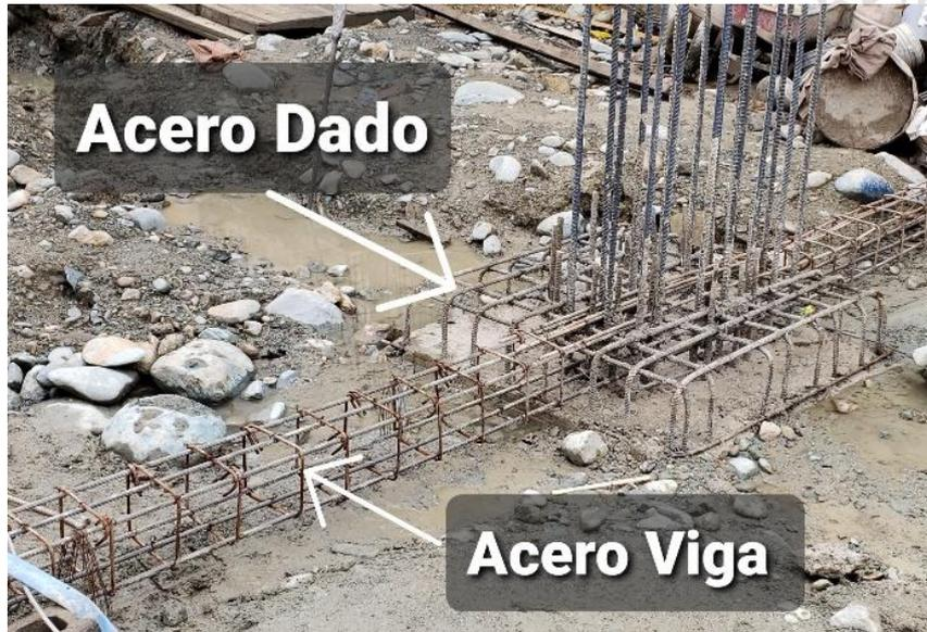
Imagen 18. Estructura de acero de la viga
