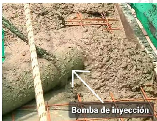
Imagen 44. Vaciado de concreto de la losa. Imagen tomada del video ¿Cómo se hace el vaciado de una losa de entresuelo?
