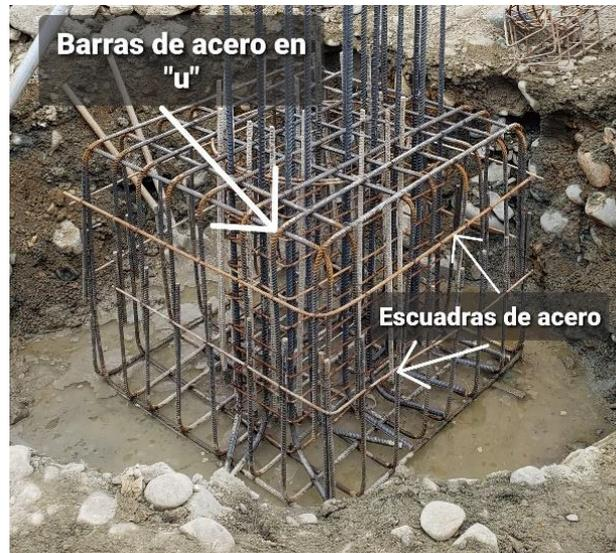
Imagen 9. Estructura de acero del dado
