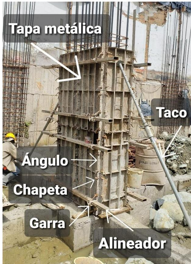
Imagen 25. Encofrado de la columna
