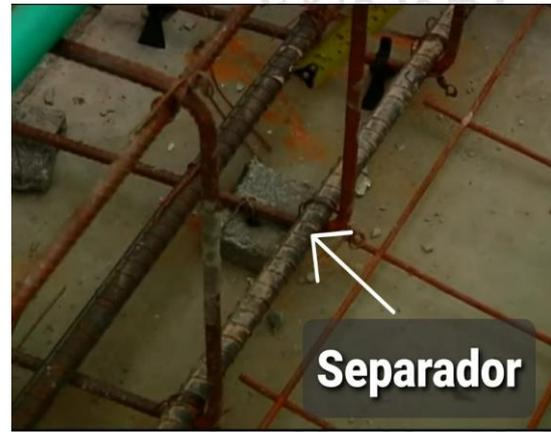
Imagen 43. Separador de concreto. Imagen tomada del video Armado de losa de entresuelo.
