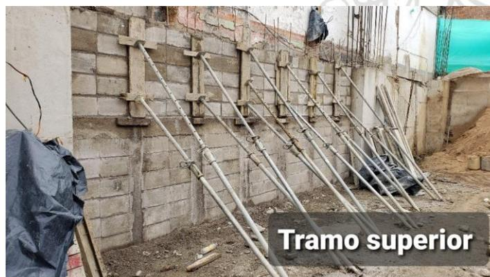
Imagen 39. Encofrado y vaciado de concreto del tramo superior del muro de contención
