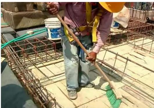
Imagen 40. Limpieza del encofrado. Imagen tomada del video Armado de losa de entresiso.
