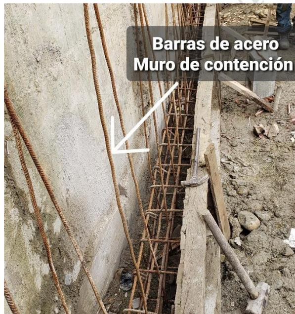
Imagen 17. Refuerzo de acero muro de contención tipo cortina
