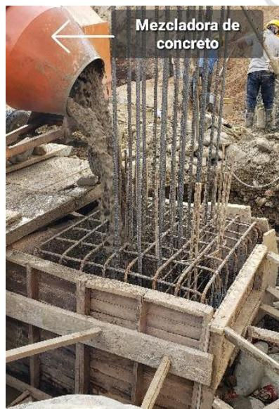
Imagen 11. Proceso de vaciado de concreto del dado
