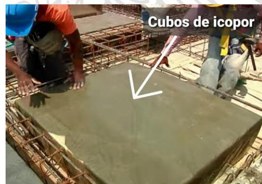
Imagen 41. Instalación cubos de icopor. Imagen tomada del video Armado de losa de entresiso.
