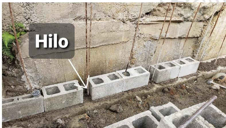
Imagen 32. Alineamiento e instalación de bloques de concreto
