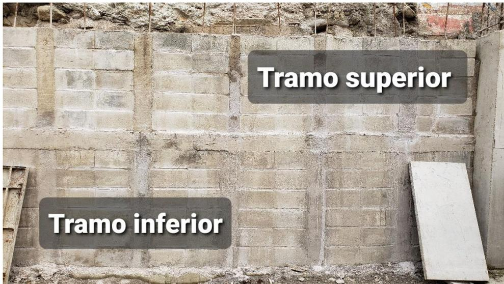
*Imagen 40. Muro de contención tipo cortina*
