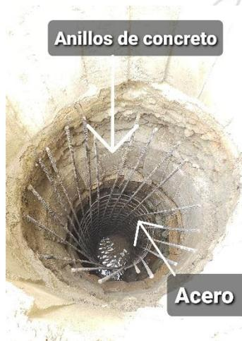
Imagen 3. Fuste reforzado con anillos de concreto
