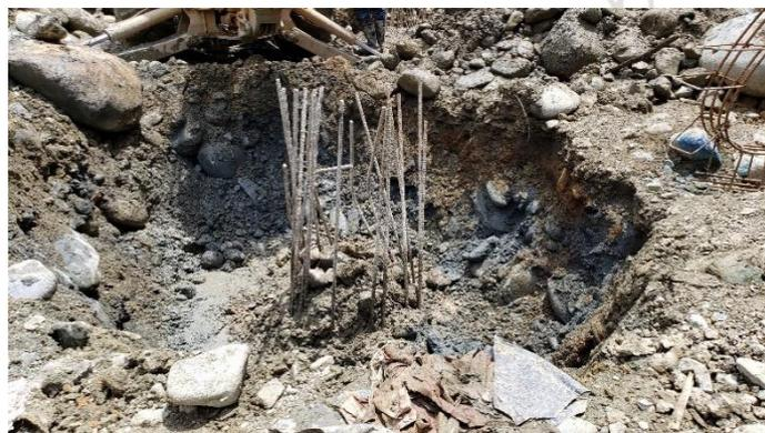
Imagen 7. Excavación del dado
