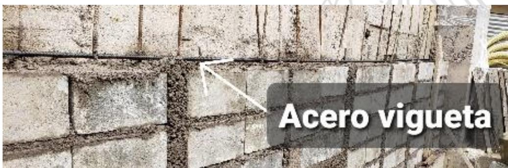
Imagen 36. Refuerzo de acero de la vigueta
