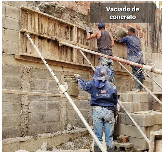
Imagen 35. Vaciado de concreto en el muro de contención
