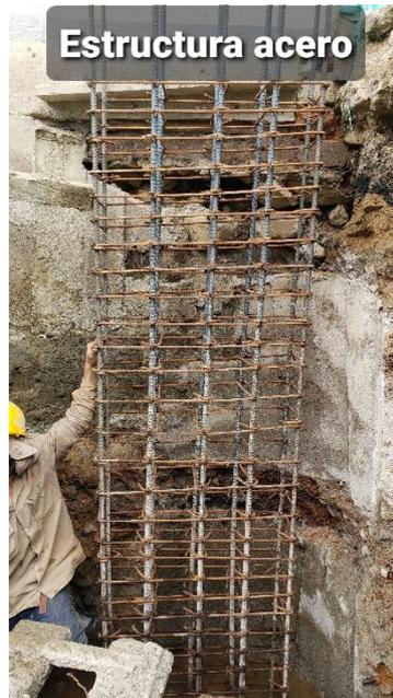
Imagen 24. Estructura de acero de la columna
