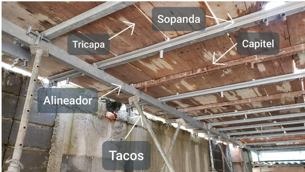
Imagen 41. Equipo de encofrado de losa
