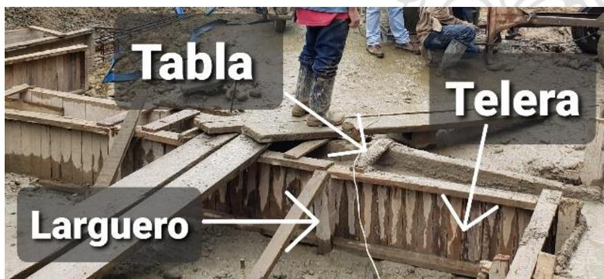
Imagen 19. Encofrado de la viga
