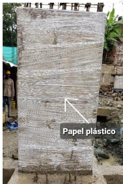
*Imagen 29. Columna en proceso de curado del concreto*
