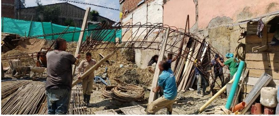
*Imagen 5. Instalación canasta de acero*
