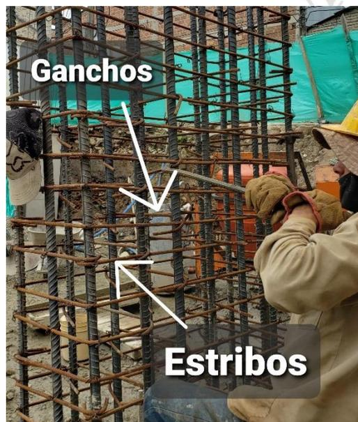
Imagen 23. Estructura de acero de la columna
