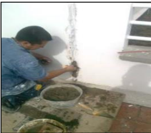
Figura 7. Resane de fisuras. Fuente: Vera (2012)
