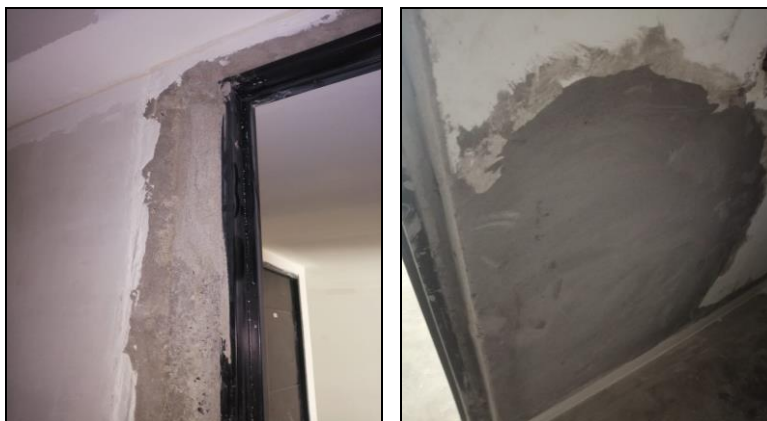
Figura 10. Marco de puertas y reproceso de revoques. 2020. Fuente: Creación propia.
