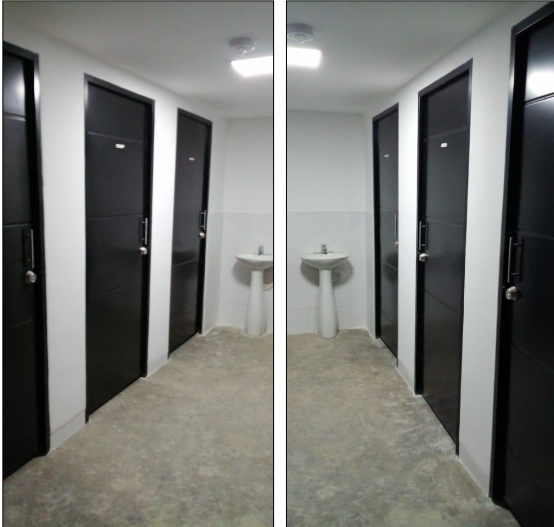
Figura 3. Baños del primer nivel de las bodegas. 2020.
