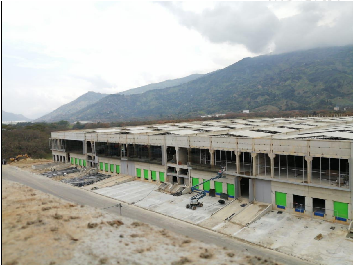
Figura 2. Fachadas de las bodegas. 2020. Fuente: Creación propia.
