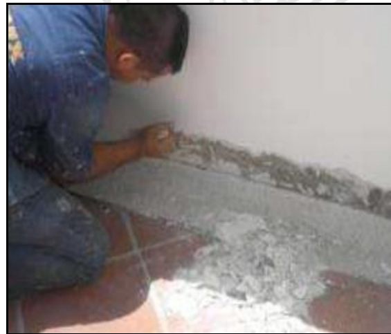
Figura 6. Raspando patera de muro. Fuente: Vera (2012)
