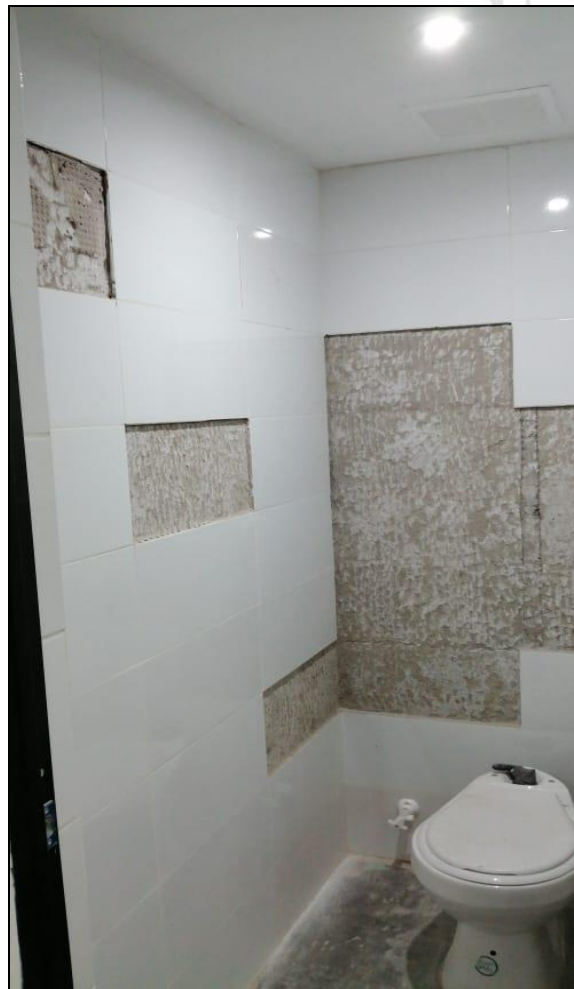
Figura 12. Reproceso en enchape. 2020. Fuente: Creación propia.
