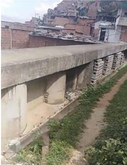
**Imagen 11.** Muro de contención, Granizal (fuente propia, 2020).
