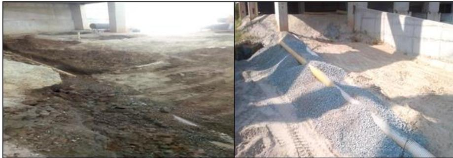
Figura 33. Colocación de tubería de aguas lluvia.
