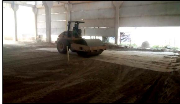
Figura 9. Compactación de suelo mediante vibrocompactador.
