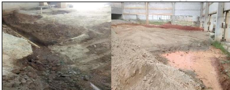
Figura 35. Fallos en las capas del lleno.
