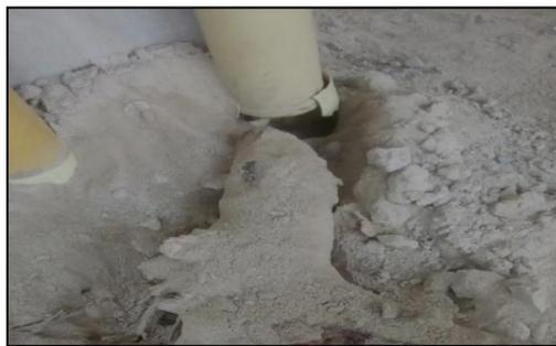
Figura 34. Ruptura de bajante durante nivelación.
