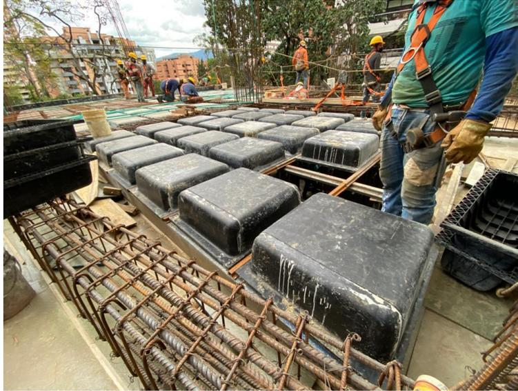
Ilustración 3. Ubicación de cajones en módulo- Edificio Brick.
