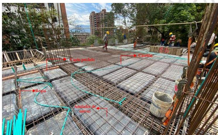
Ilustración 1. Armado de losa con casetones de ATEX- Edificio Brick.
