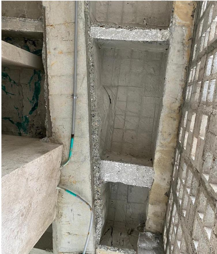
Ilustración 7. Zonas con consumo adicional de concreto por deterioro en porones- Edificio Boschetto.
