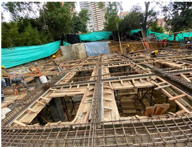
Ilustración 2. Zonas con laterales para vigas profundas- Edificio Brick.
