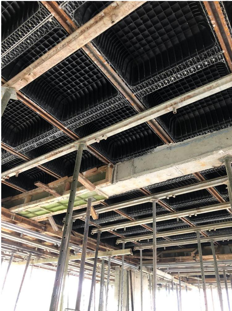
Ilustración 4. Parte inferior de casetones para proceso de desencofrado- Edificio Brick.
