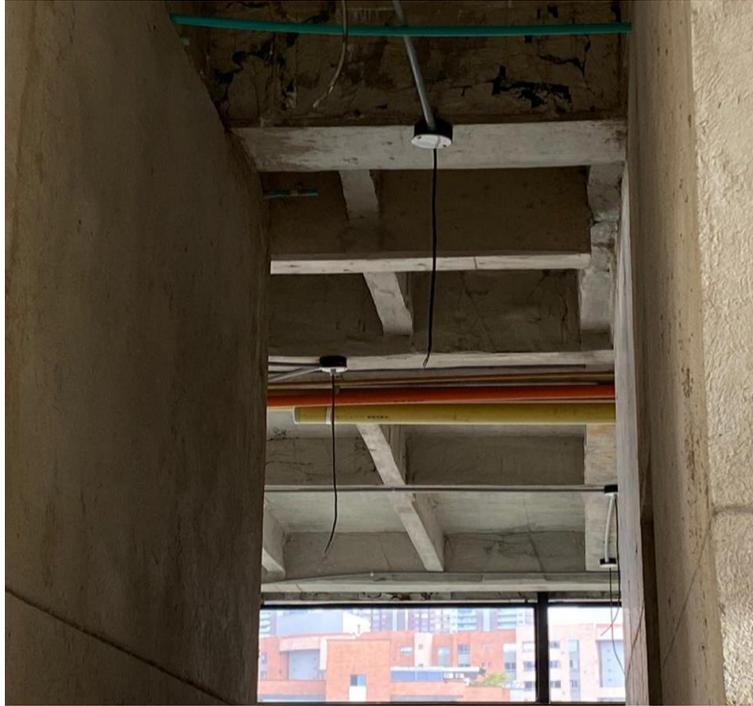
Ilustración 6. Losa con encofrado tradicional con porones- Edificio Boschetto.
