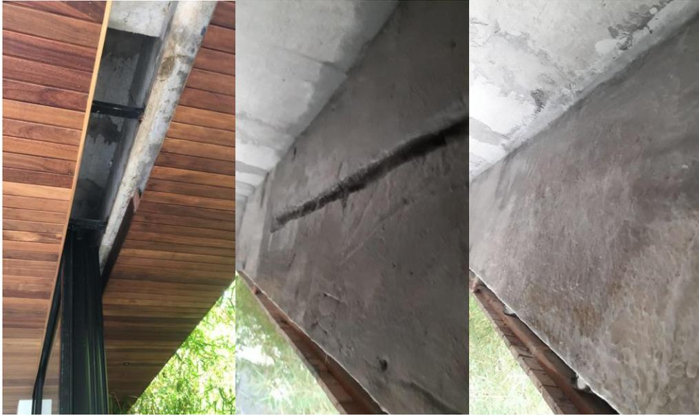
Ilustración 12. Tratamiento de fisuras en pared externa de jardineras- Edificio Boschetto.
