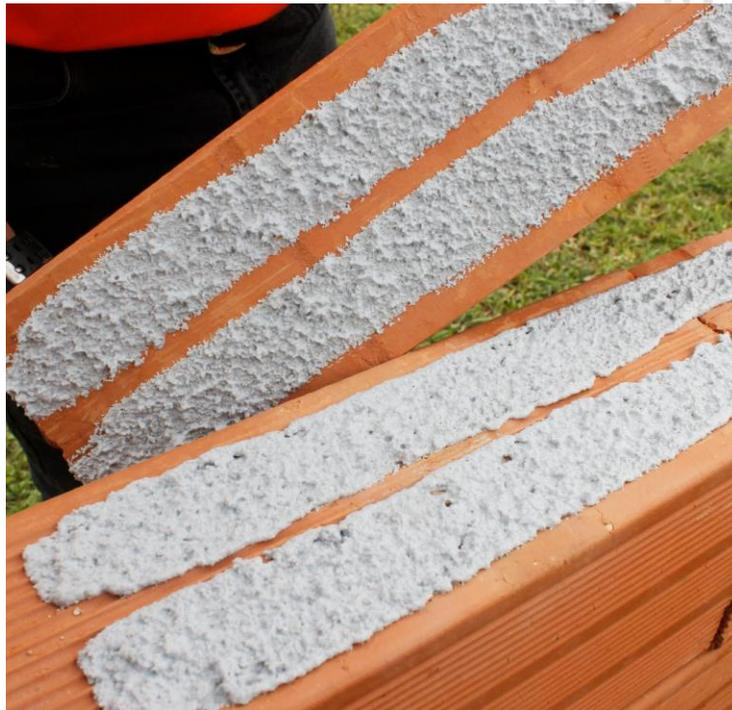
Ilustración 15. Aplicación de Brickaffix para levantamiento de muros de mampostería. Cortesía: Bricka S.A.S
