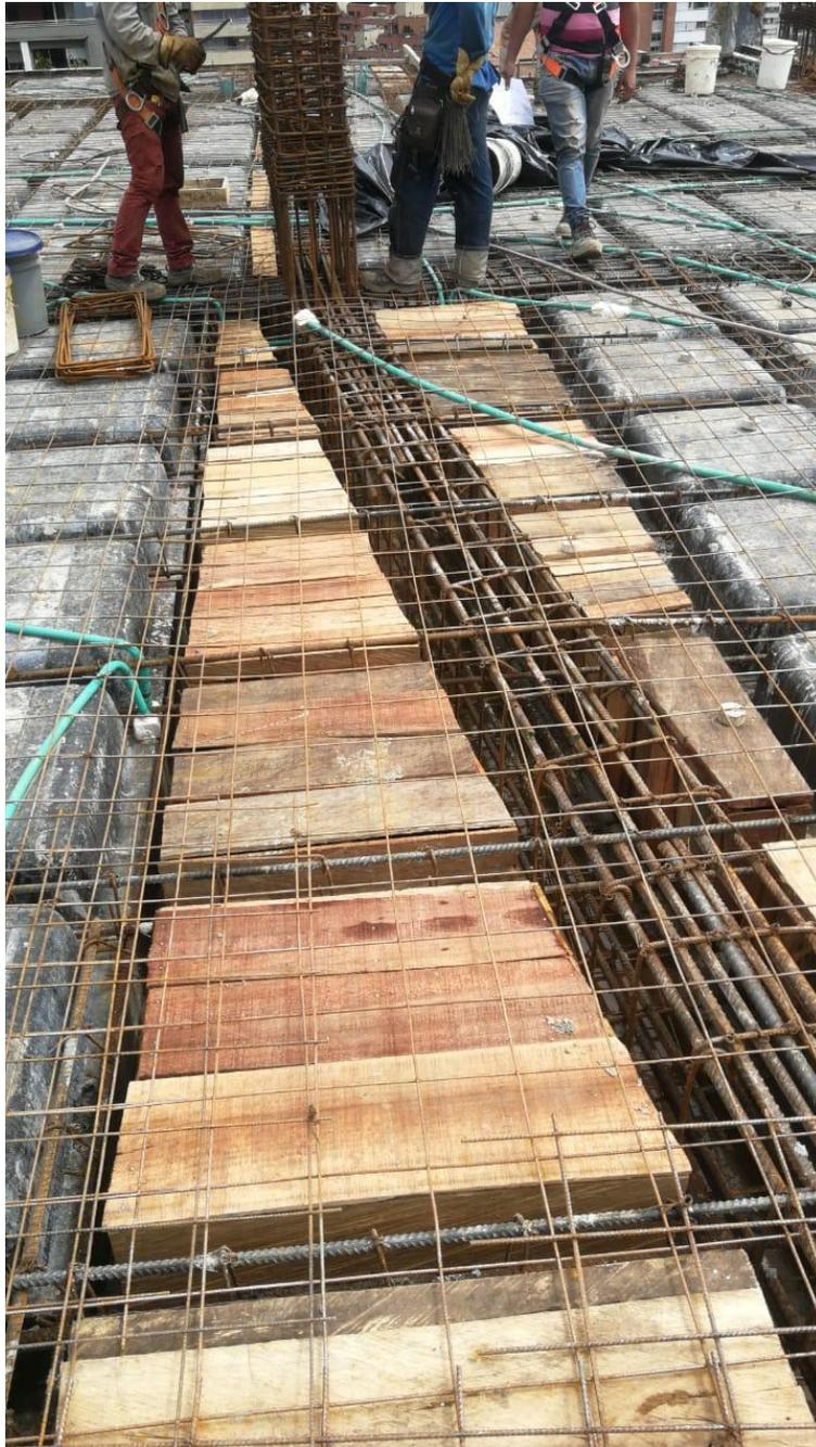
Ilustración 10. Recuperación de material en losas, zonas de ajustes por modulación- Edificio Brick.
