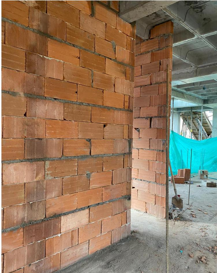
Ilustración 16. Muros con uso de Brickaffix, supervisión técnica de ubicación de grafil- Edificio Brick.
