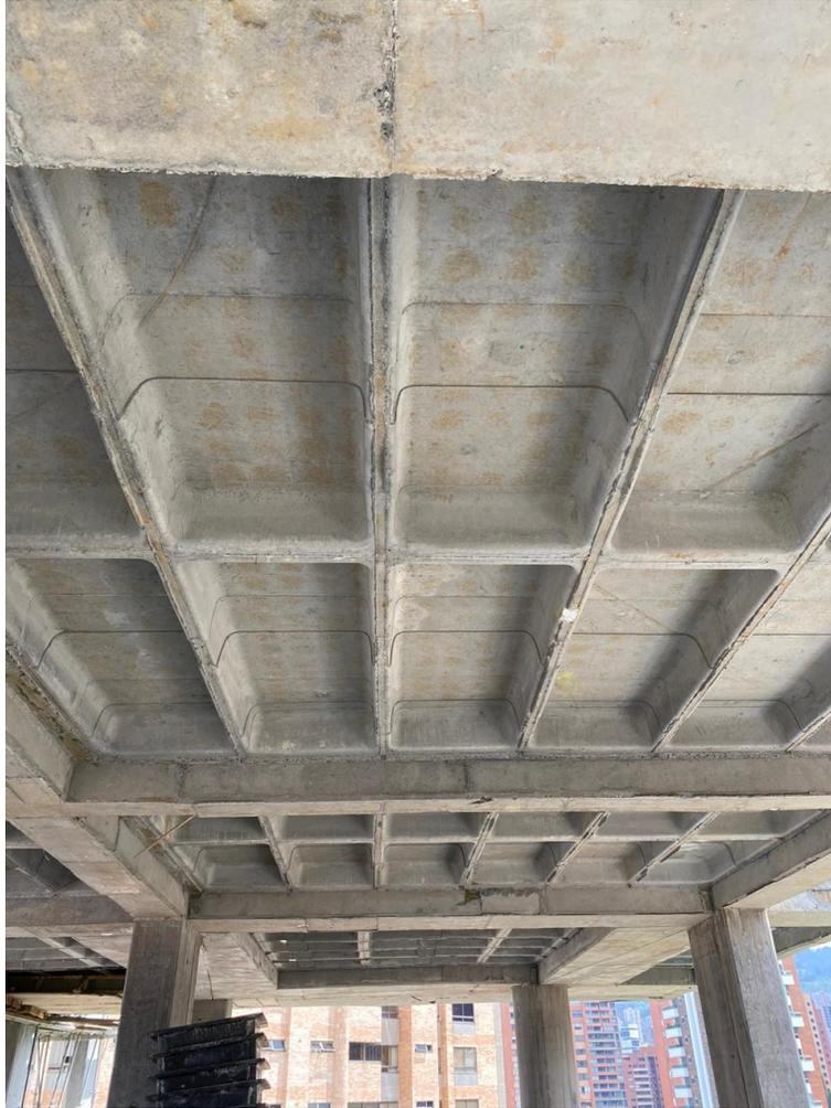
Ilustración 9. Acabados de losa una vez desencofrado, zona social- Edificio Brick.
