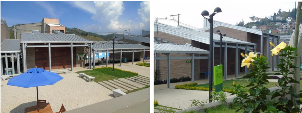
Infraestructura Parque Educativo Cuna de la Libertad. Derechos de autor: Andrés Gómez.
