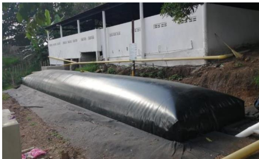
Figura 6. Biodigestor fabricado en polietileno linear de baja densidad (LLDPE).
