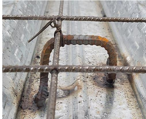
**Imagen 12:** Unión entre conector y malla
