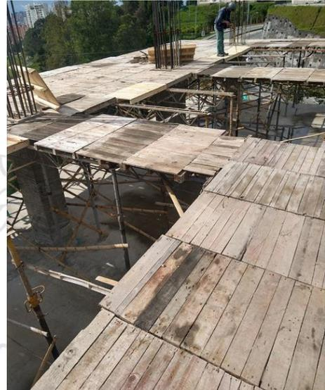
Imagen 4: Encofrado inferior para vigas aéreas
