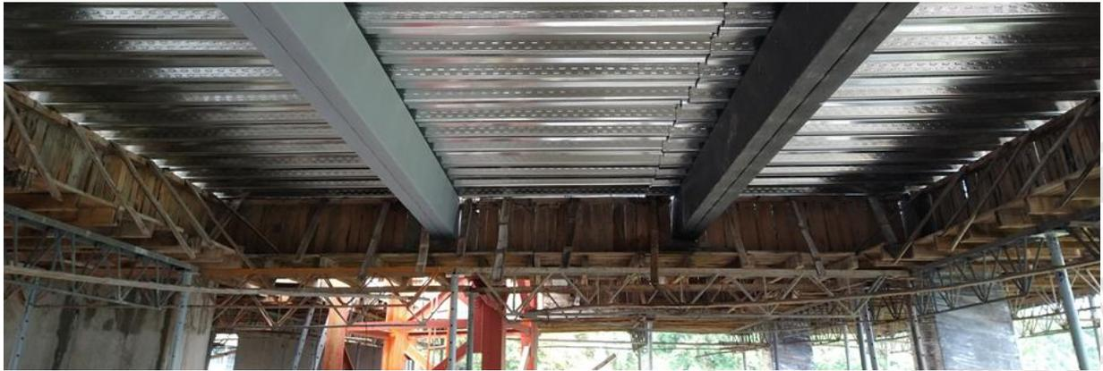
**Imagen 14 y 15:** Vista inferior de losa, encofrado de vigas aéreas y disposición de lámina metaldeck
