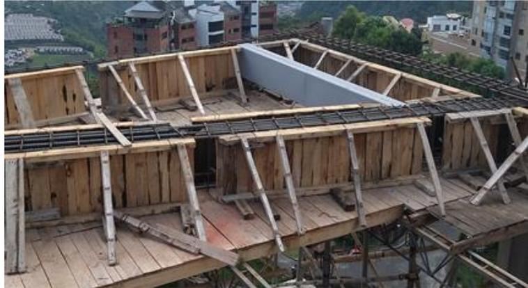
**Imagen 7:** Viga V2 armada, encofrada y espacios para viguetas
