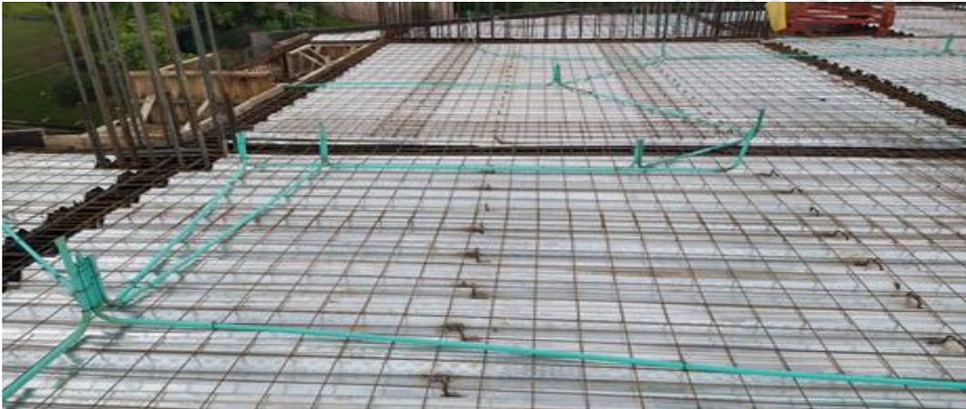
**Imagen 16:** Vista superior de losa antes de fundida e instalación de tubería eléctrica
