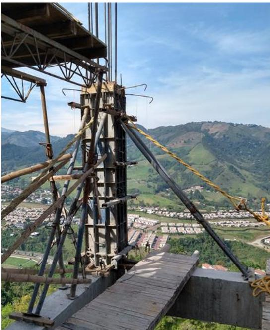
**Imagen 1:** Encofrado de columna
