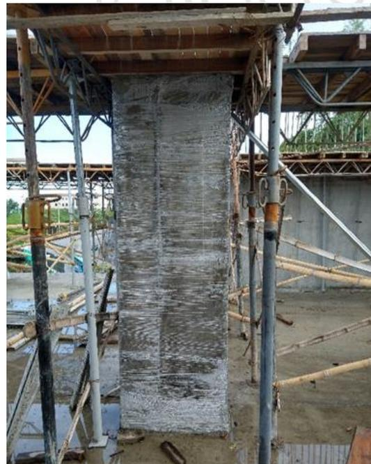
**Imagen 2:** Columna desencofrada y envuelta en cristaflex
