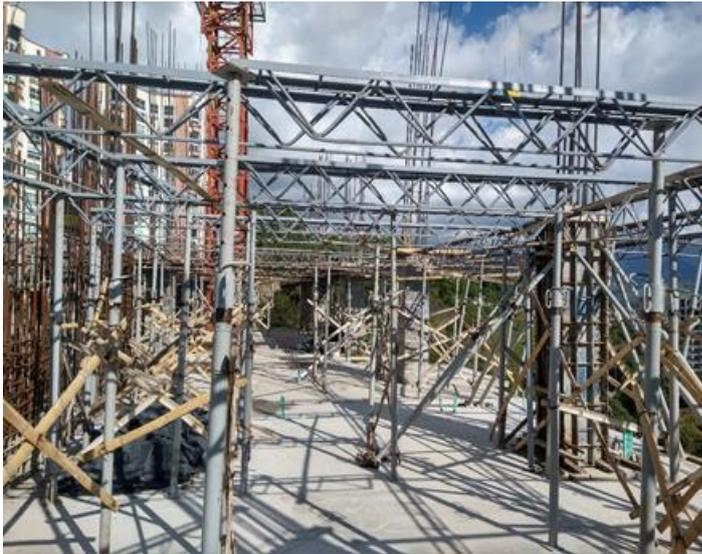
Imagen 3: Instalación de cerchas para encofrado nivel superior
