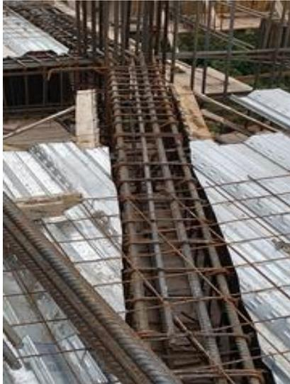
**Imagen 6:** Conformación de acero en viga
