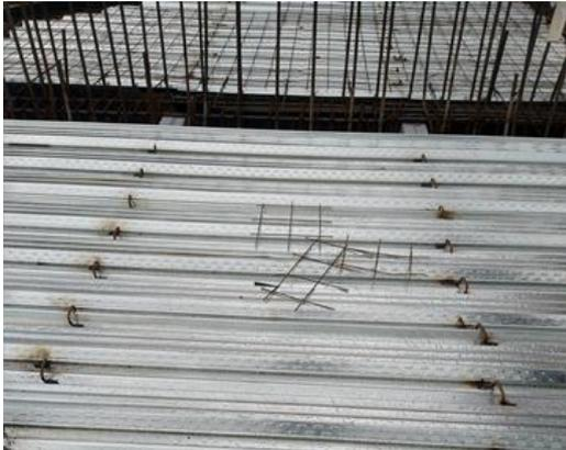
**Imagen 11:** Instalación de conectores
