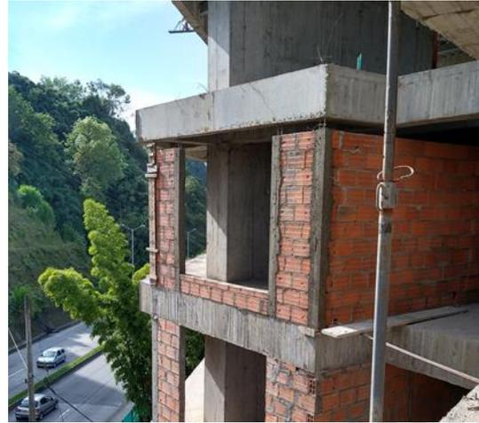
**Imagen 19 y 20:** Columnas de amarre entre muro y columna estructural, columna de amarre en fachada
