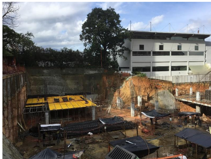
Figura 42: Registro fotográfico armado de losa.
