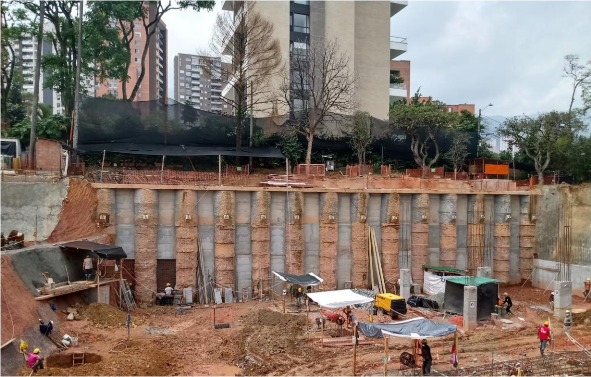
Figura 18: Registro fotográfico del sistema de contención.
