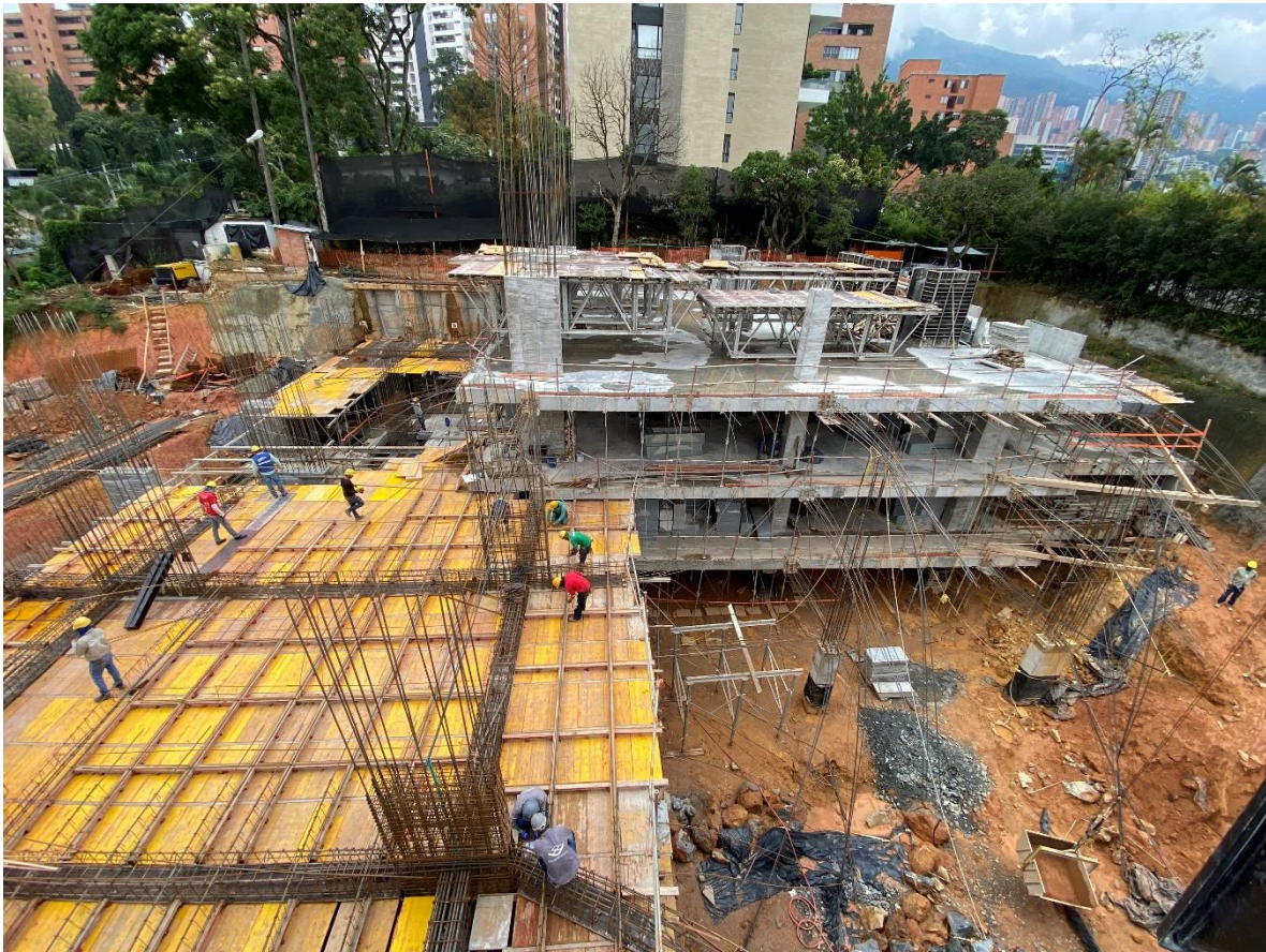
Figura 49: Registros fotográficos armado y vaciado de losas.
