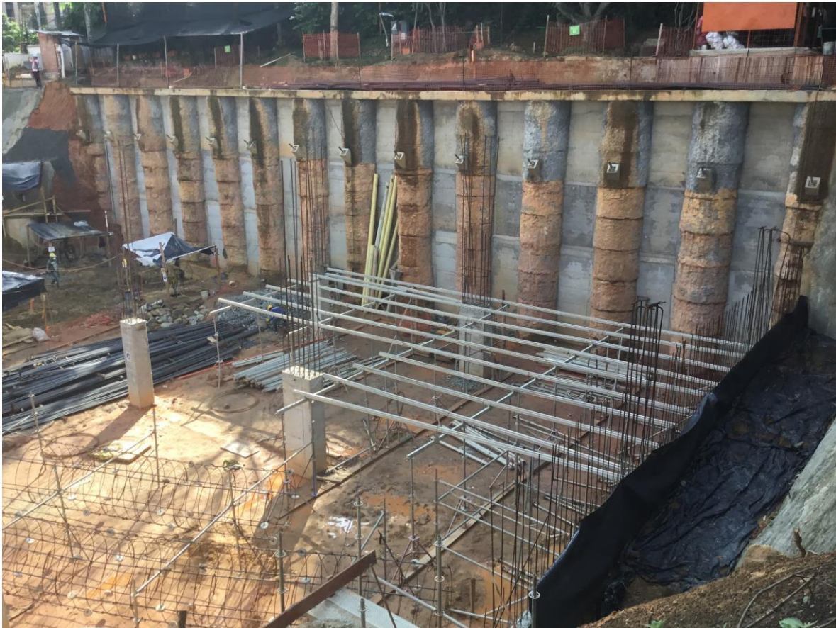
Figura 40: Registro fotográfico inicio de armado losa nivel 1548 msnm.
