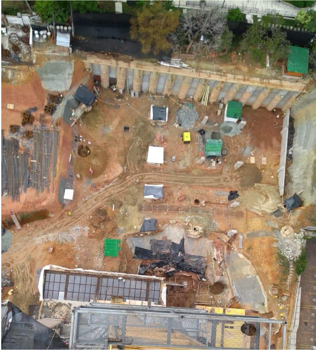
Figura 32: Excavación total del conjunto de pilas de fundación.
