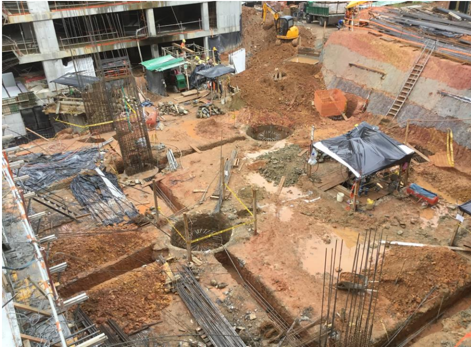
Figura 31: Excavación parcial del conjunto de pilas de fundación.
