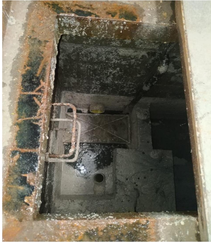
Imagen 3. Trampa de grasas después de haber presentado reboses.
