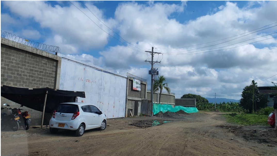
Foto 2. Plano general parte externa de la construcción, divisa puerta de ingreso al proyecto.
