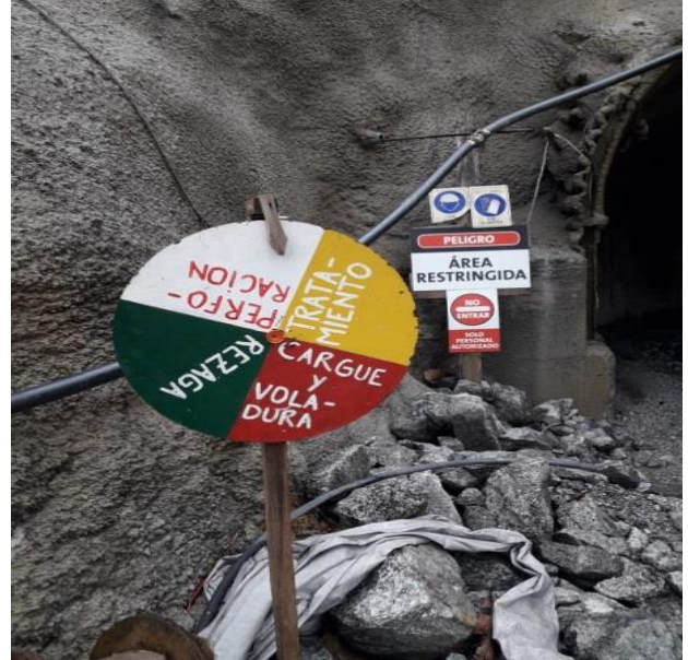
Figura 19. Indicador de actividades en el ciclo de excavación. Elaboración propia
