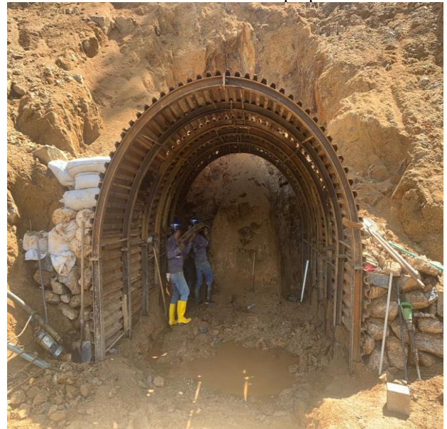
Figura 20. Instalación de marcos metálicos como medida de seguridad ante el inicio del proceso de excavación. Elaborado por: Ing. Ricardo Arboleda
