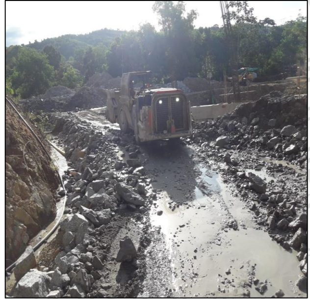
Figura 15. Proceso de rezaga mediante el cargador de bajo perfil. Elaboración propia
