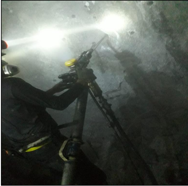
Figura 13. Perforación manual del frente de ataque. Elaboración propia
