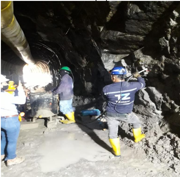
Figura 18. Tratamientos mediante inyecciones de consolidación. Elaboración propia
