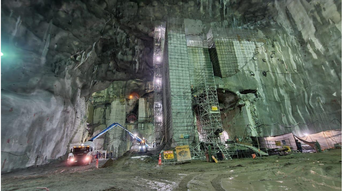
Ilustración 2. Vista desde almenara 1 de la oquedad y el concreto dental vaciado. Fuente propia.
