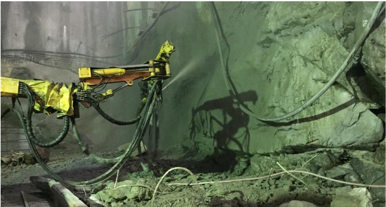
Ilustración 3. Estabilización de un macizo de rocoso en Almenara 1 con concreto lanzado. Fuente propia.
