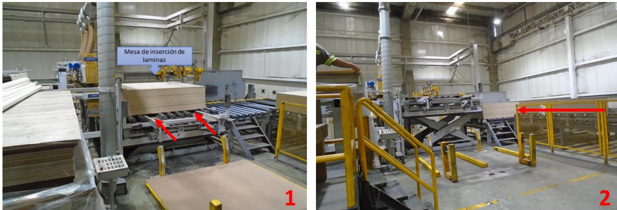
Ilustración 4: Línea de inserción de tableros.
