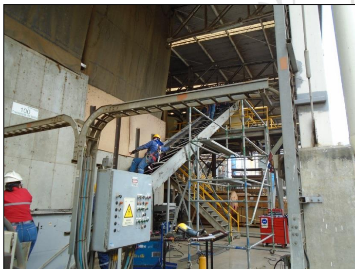
Imagen 10 Falla mecánica en la banda REDLER
