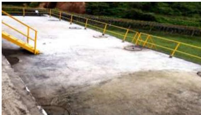
**Fotografía 8.** Losa superficial y cámaras de inspección del FAFA Santo Domingo
