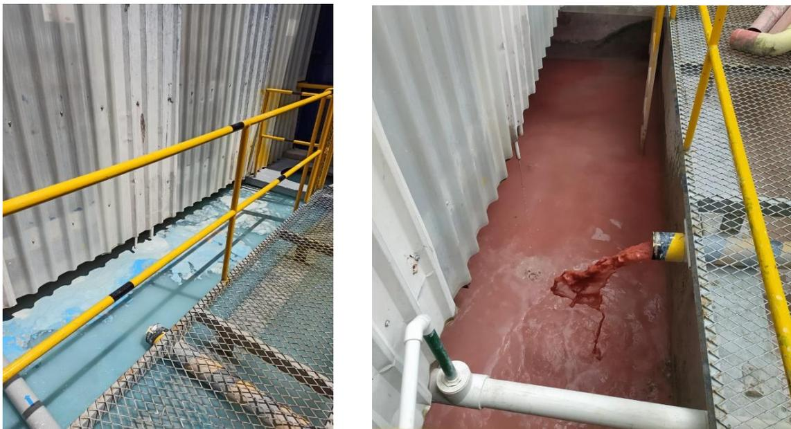
*Imagen 4. Tanque Homogeneizador contaminado por esmaltes.*
