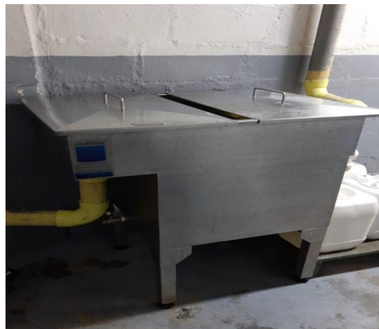
Imagen 8. Trampa de grasas cuarto de residuos. Fotografía tomada por la estudiante Valentina Mesa Quintero.
