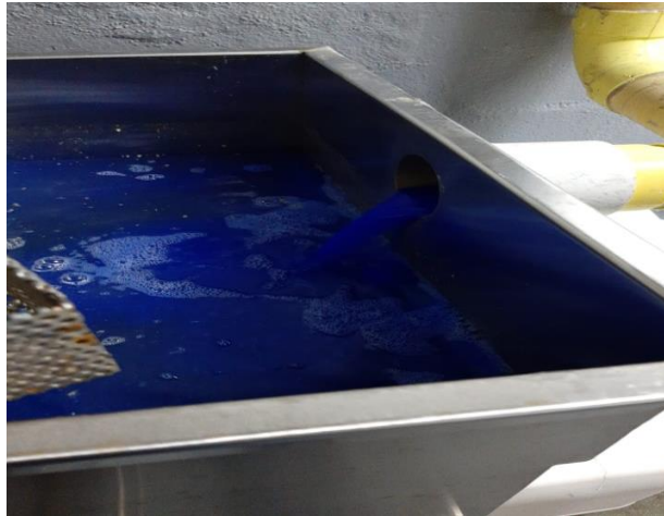
Imagen 9. Verificación conexión área de carnicería con trampa de grasa. Fotografía tomada por la estudiante Valentina Mesa Quintero.
