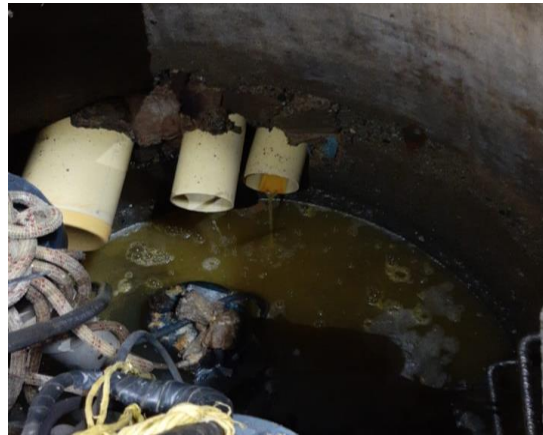
Imagen 7. Descarga de carnicería en Manjole del parqueadero. Fotografía tomada por la estudiante Valentina Mesa Quintero.
